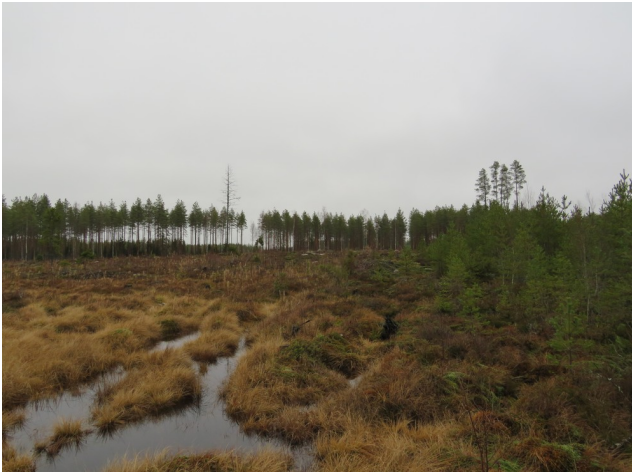
15. Ulkopuolisen sähkökaapelin linjausta Övermarkintien varrella, kuva pohjoiseen.
