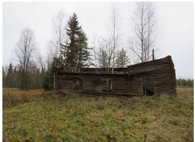
Kuva 39. Rakenne 1, talo pohjoiseen.
