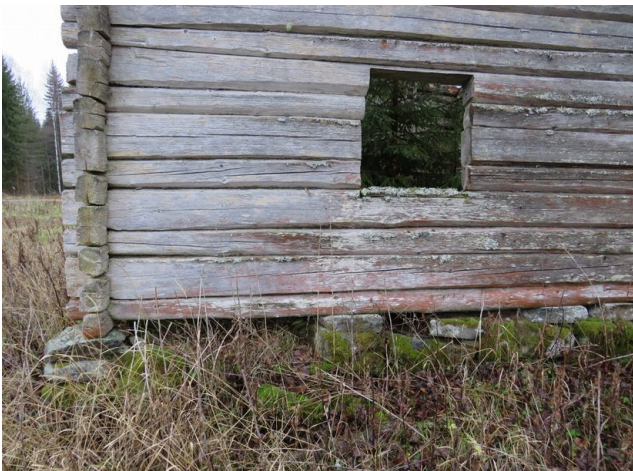
Kuva 38. Rakenne 1, talon koillisnurkka.
