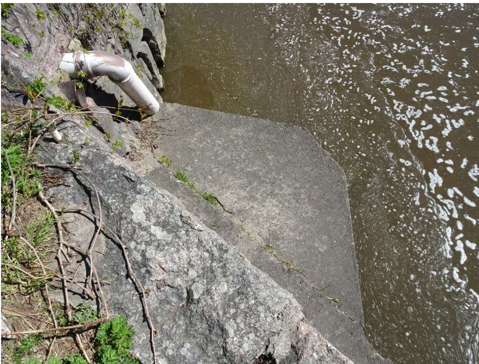
Kuva 13. Kohde 6: betonitaso kuvattuna ylhäältä päin, Kuninkaankartanonsaaren rantamuurin kulmauksesta. Mikäli kuvassa näkyvät putket liittyvät betonitasoon, on kyseessä todennäköisesti vesilaitoksen toimintaan liittyvä rakenne. Kuva: E. Vakkari 30.5.2020.
