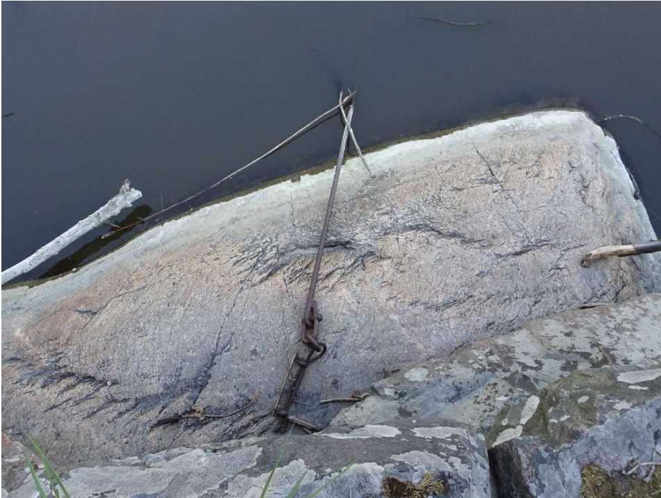
Kuva 11. Kohde 5: kiinnityslenkki ja vaijeri kalliossa kosken länsihaaran suulla. Uudehkot lenkki ja vaijeri liittyvät mahdollisesti voimalaitokseen. Kuva: E. Vakkari 30.5.2020.
