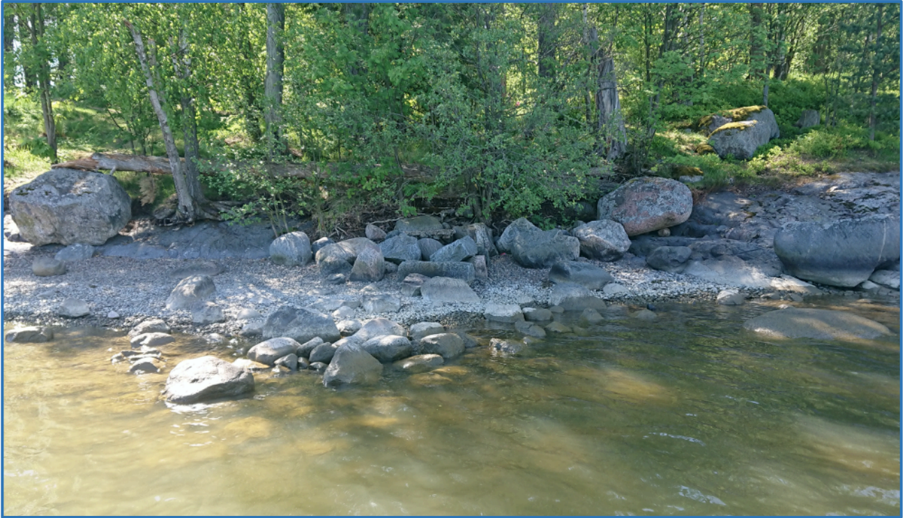
Kuva 11. Laiturin ja uimahuoneen kiviperustus jatkuu veden alle 1,7 metrin syvyyteen. Kiviä on levinnyt ympäristöön alkuperäisestä sijainnistaan.
