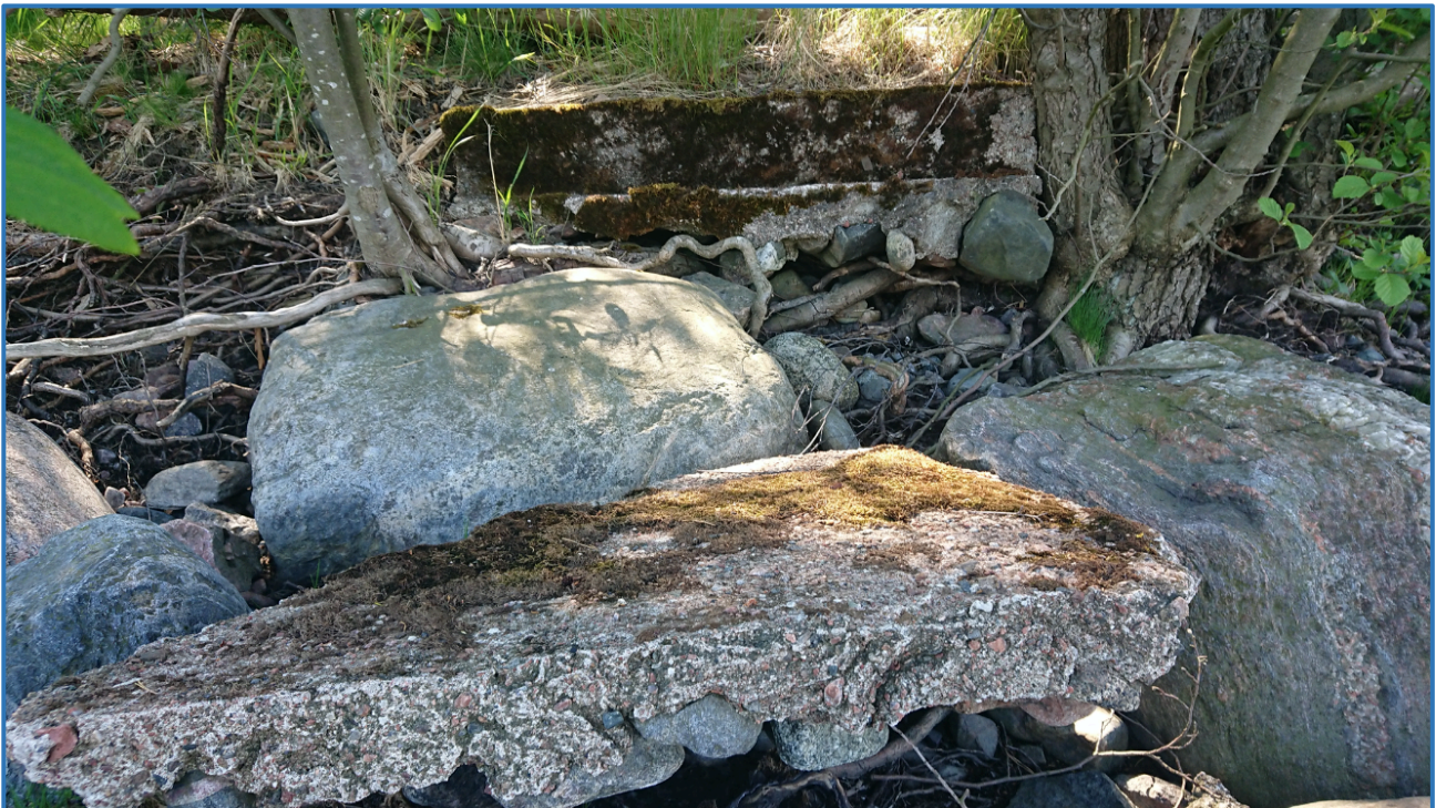
Kuva 10. Uimahuoneelle johtaneiden betoniportaiden jäänteet rantapenkereessä.
