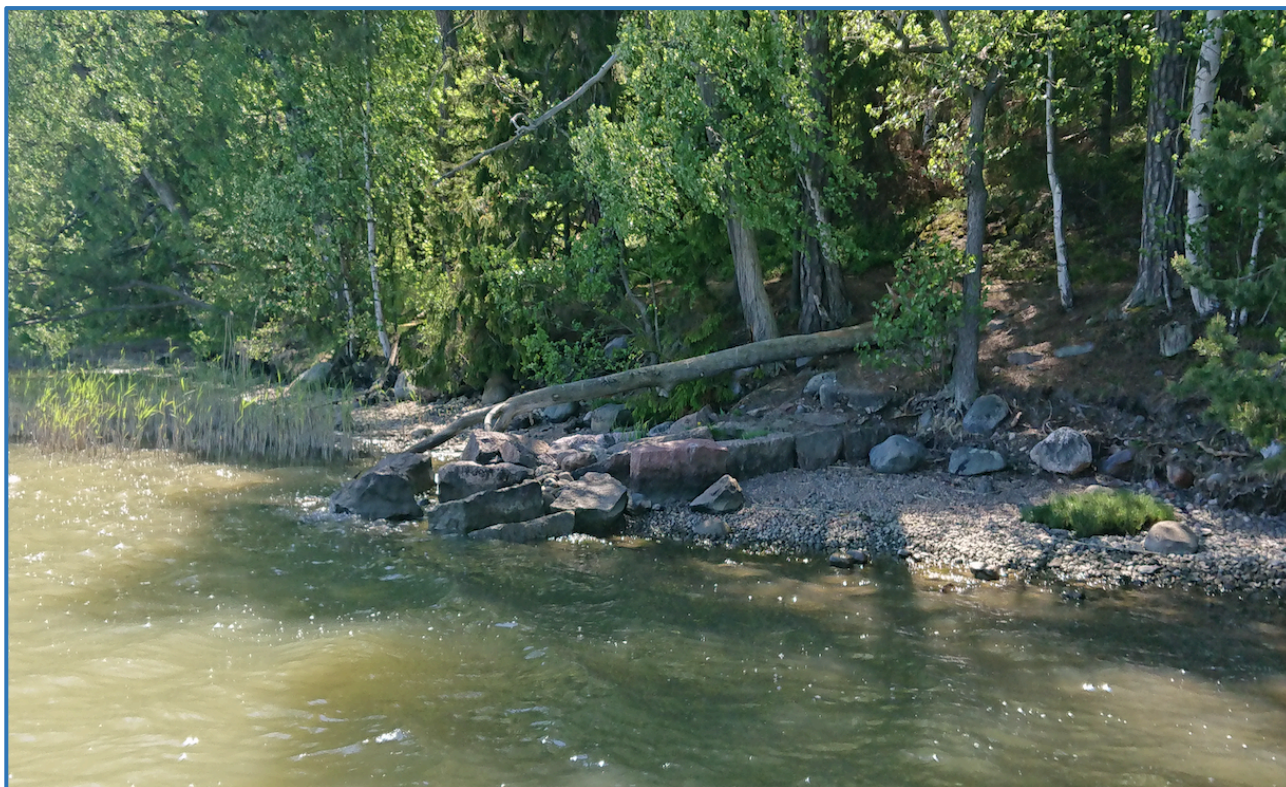
Kuva 12. Laiturista on jäljellä harkkokivistä ja luonnonkivistä muodostuva perustus, joka jatkuu veden alle.
