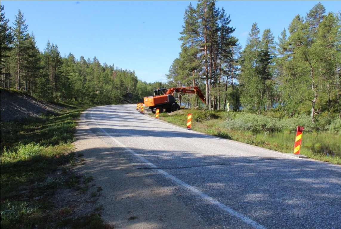
Akdg6445:5 Työkuva. Pyyntikuopan kaivu kaivinkoneella alkaa. Koillisesta.
