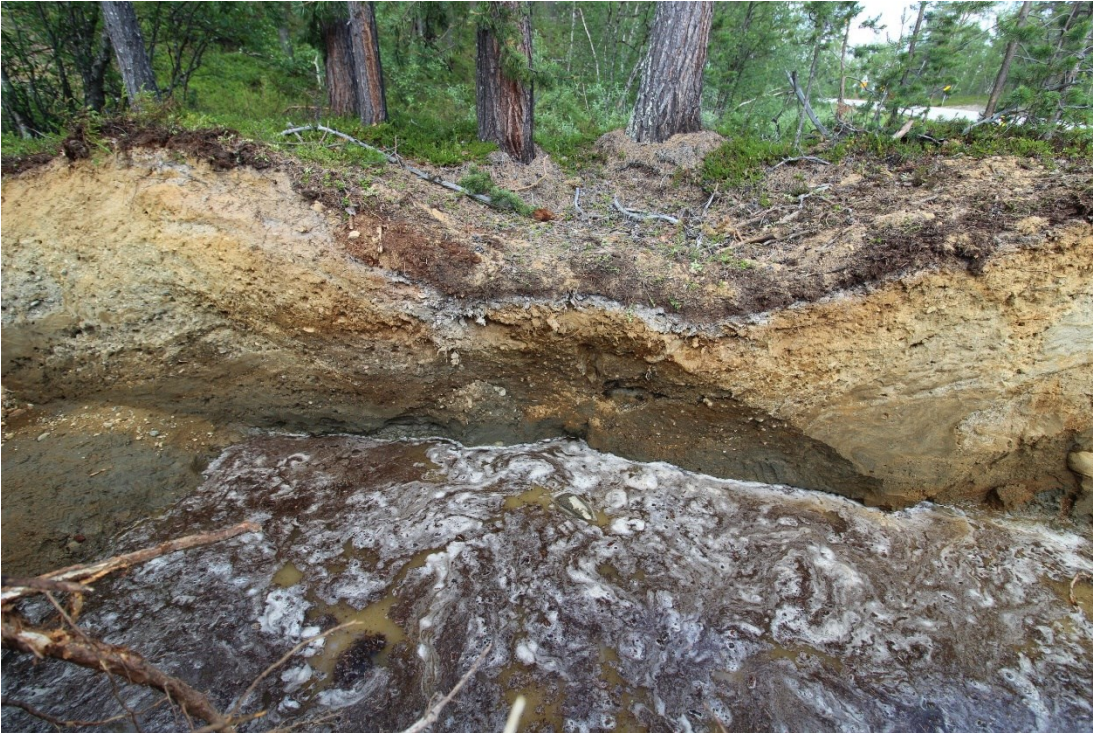
Akdg6445:20 Pyyntikuopan keskikohdan täyttömaa on sortunut.
