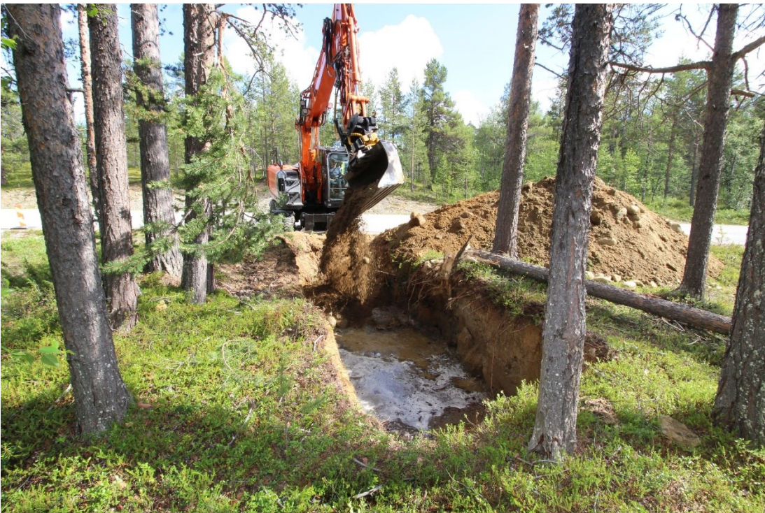
Akdg6445:22 Työkuva. Kaivantoa täytetään. Lännestä.
