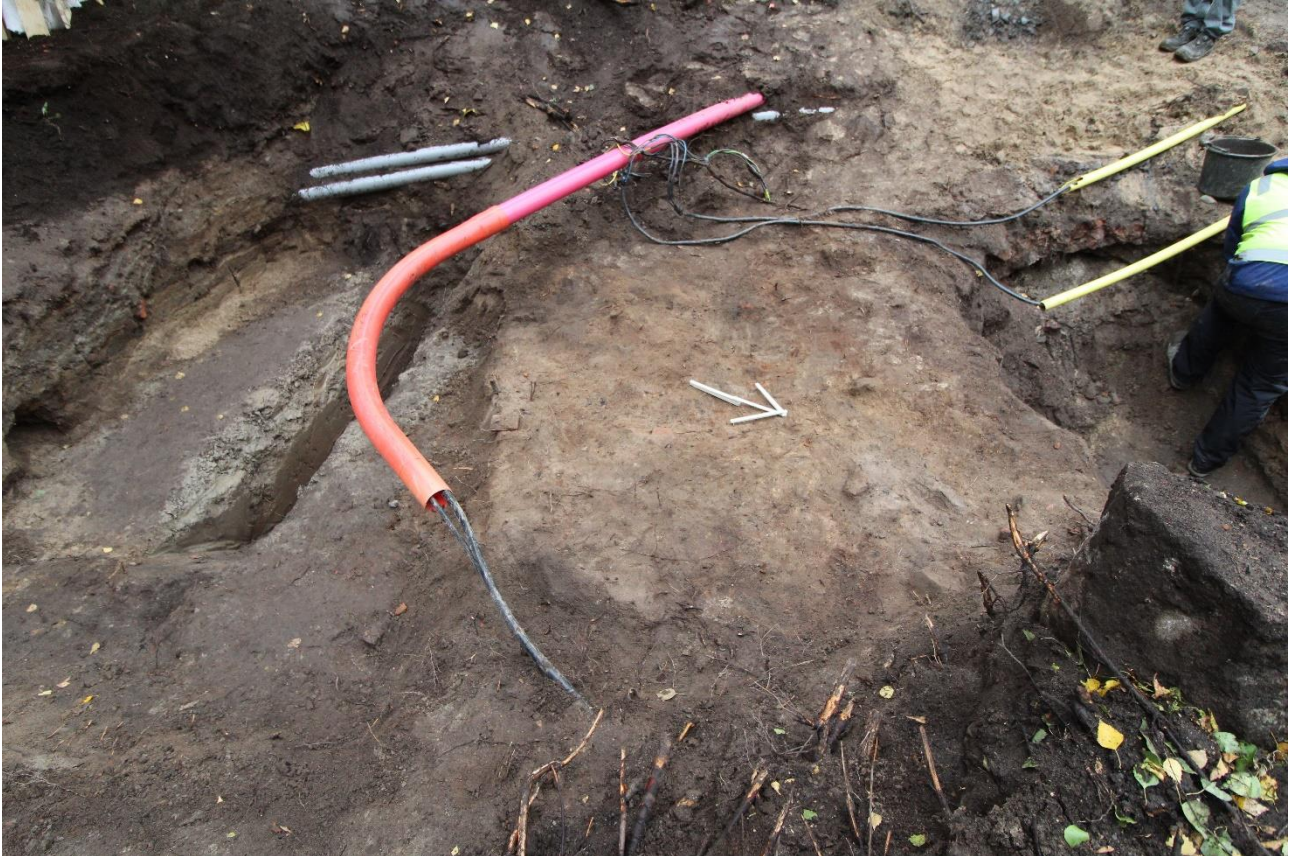
AKDG6460:159. Alueen 3 koillisosa. Kuvan vasemmassa reunassa kaivinkoneella kaivettu alue ja pohjamaahan kaivettu koeoja 3. Kuvan oikeassa reunassa Snellmaninpuiston koekaivausten aikana kaivettu koekuoppa 8. Kuvan keskellä Y214 ja Y221. Koillisesta. Kuva: Matleena Riutankoski
