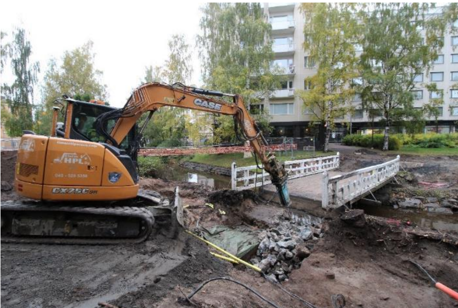
AKDG6460:172. Sillan luoteispäädyn betonianturaa rammeerataan. Ete- lästä. Kuva: Matleena Riutankoski
