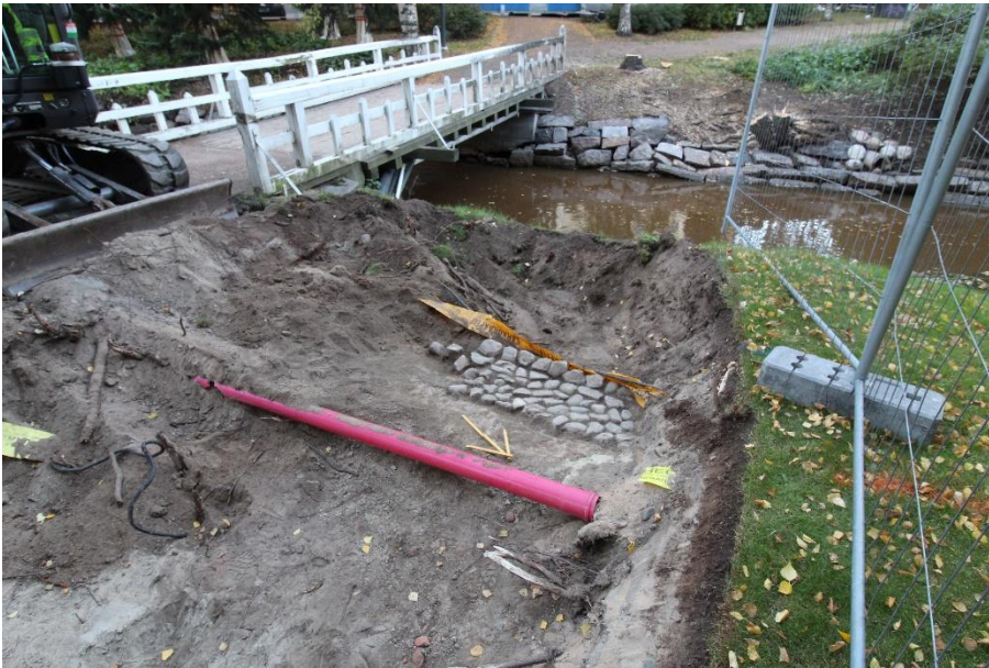
AKDG6460:46. Mukulakivirakenne R101. Koillisesta. Kuva: Matleena Riutankoski
