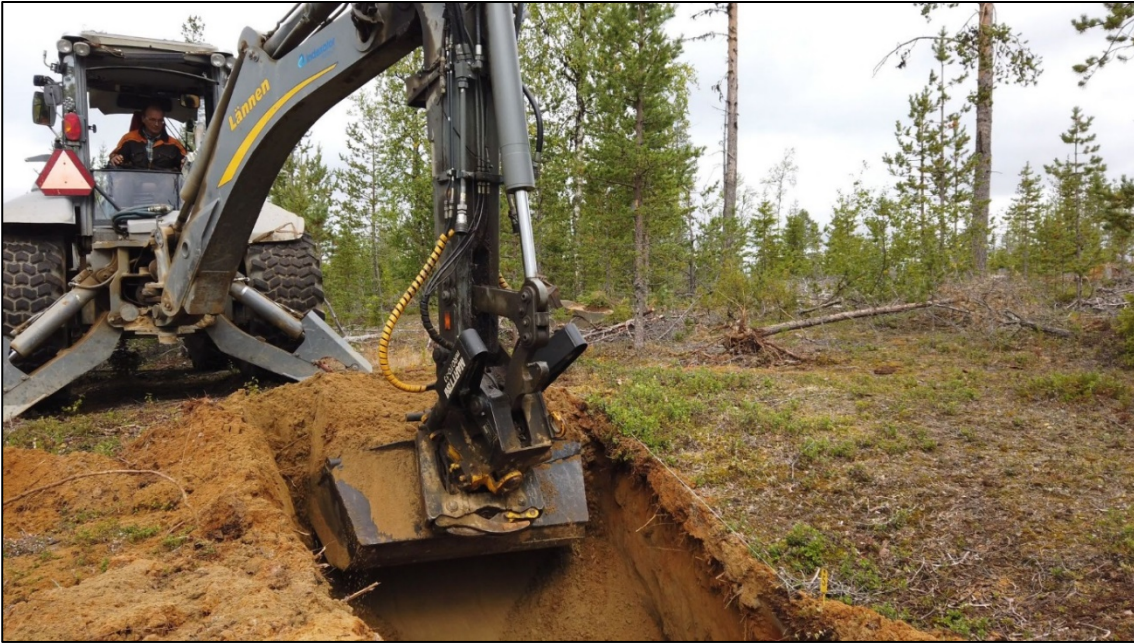
Kuva 3. Pyyntikuoppaan avataan koejaa kaivinkoneella. Kuva lounaasta. (AKDG6123:2).
