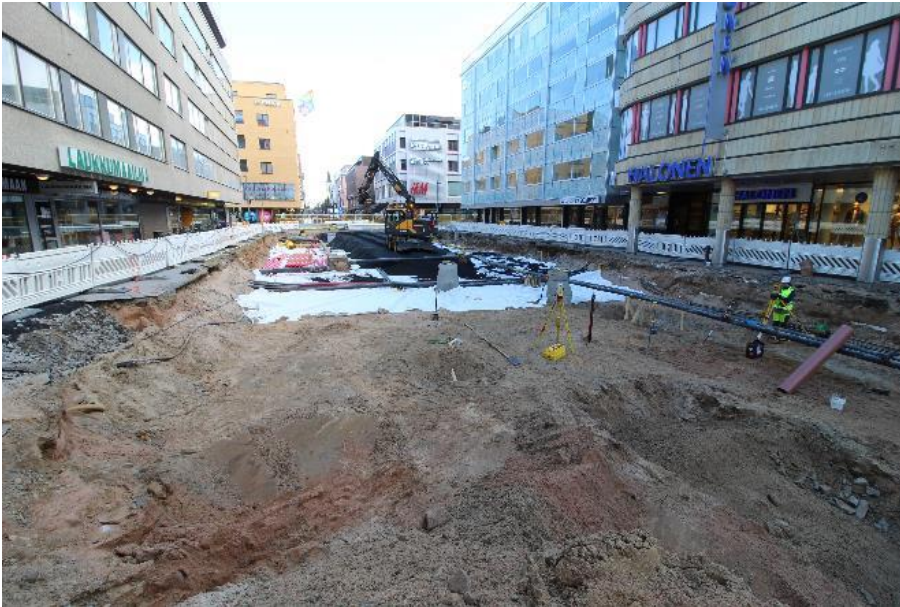
AKDG6315:82. Valvonta-alueen keskiosaa täytetään. Lounaasta. Kuva: Matleena Riutankoski
