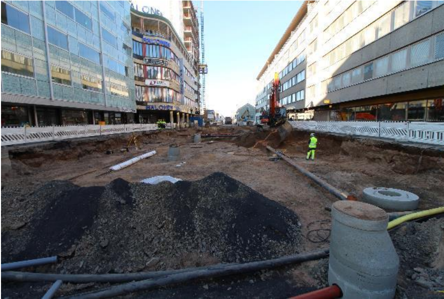
AKDG6315: 36. Terhi Tanska valvoo konekaivuuta. Koillisesta. Kuva: Matleena Riutankoski
