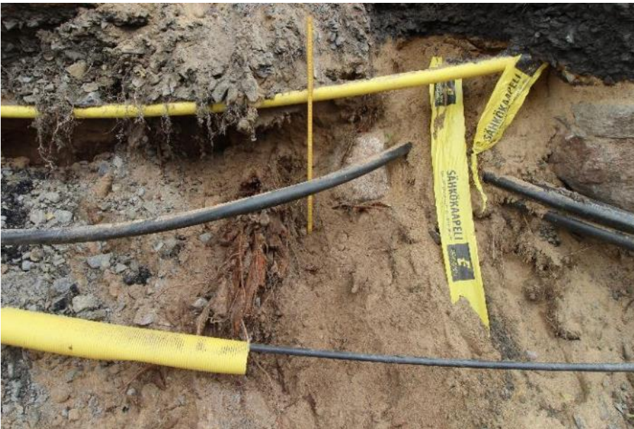
AKDG6315:131. R34AB:n lounaispäädyn kivi ja pyöreä paalu, joskin paalu romahti kaivinkonekaivuun aikana. Luoteesta. Kuva: Matleena Riutankoski
