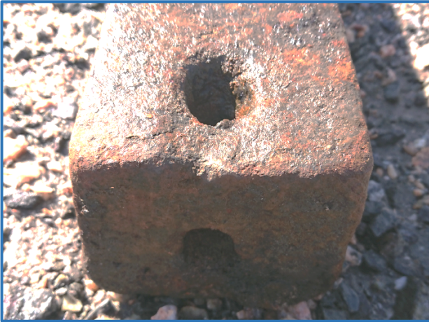
Kuva 8 ja 9. Päädyissä on reiät kiinnittämistä varten. Kyljessä on merkintä 4–2.
