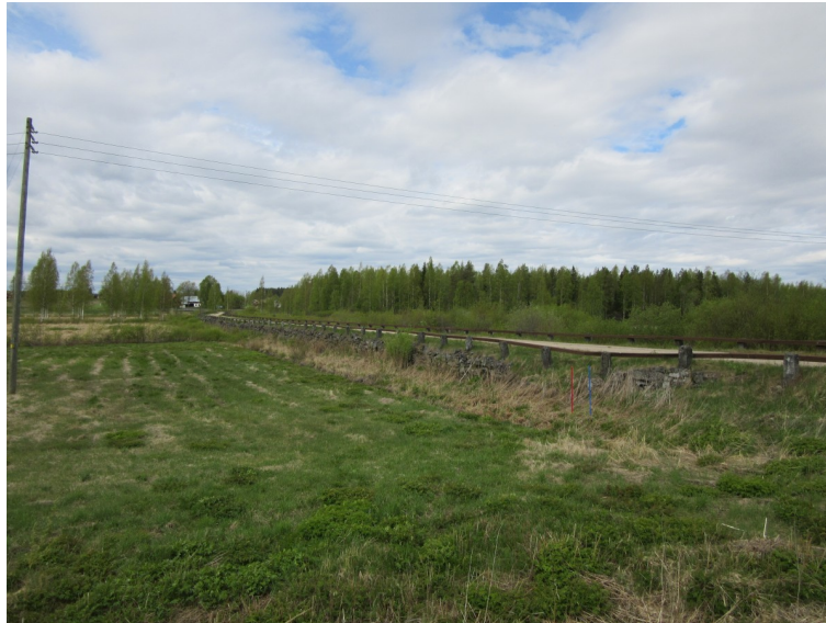
Silta Lapuantien itäpuolella, kuva luoteeseen.
