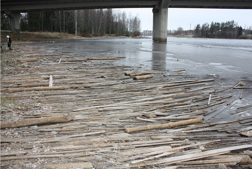
Kuva 3. Puisia rakenneosia ja puutavaraa Pielisjoen etelärannalla lähellä Pekkalan siltoja. Kuva Esa Mikkola/Museovirasto. AKDG 5994:14
