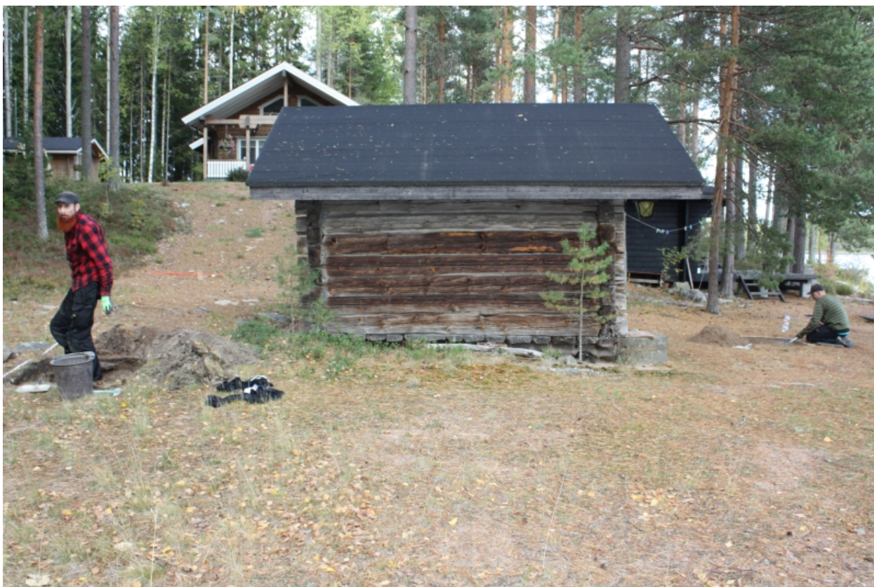
Kuva 16. AKDG5629:15 Koekuoppien 7 ja 8 sijainti suhteessa hirsivajaan. Vasemmalla Petri Suomala kaivaa koekuoppaa 7 ja oikealla Olli Eranti kuoppaa 8. Kuvattu etelästä. Kuva Esa Mikkola, Museovirasto
