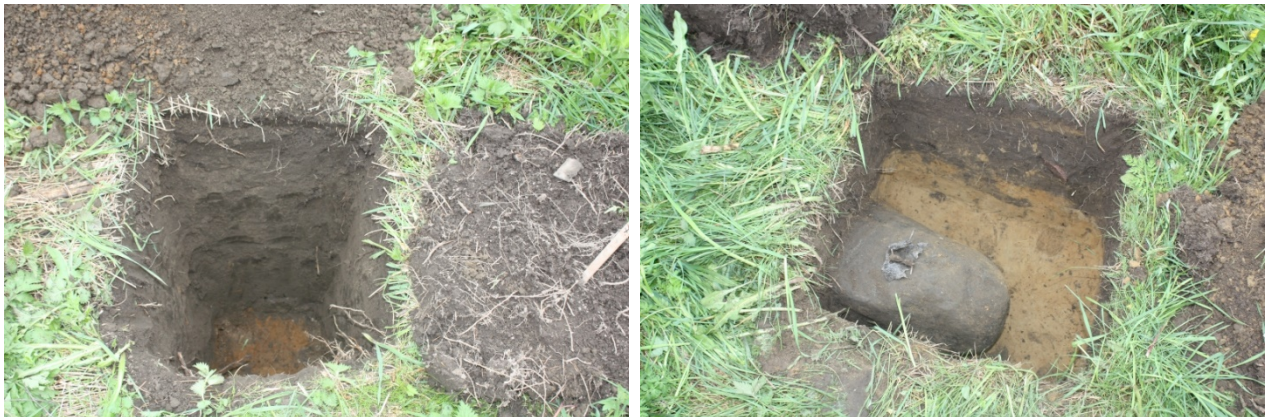
Kuvat 21 ja 22. Vasemmalla koekuoppa 7 pohjaan kaivettuna. Kuvattu etelästä. AKDG6060:19. Oikealla koekuoppa 8 pohjaan kaivettuna. Kuvattu etelästä. AKDG6060:20.
