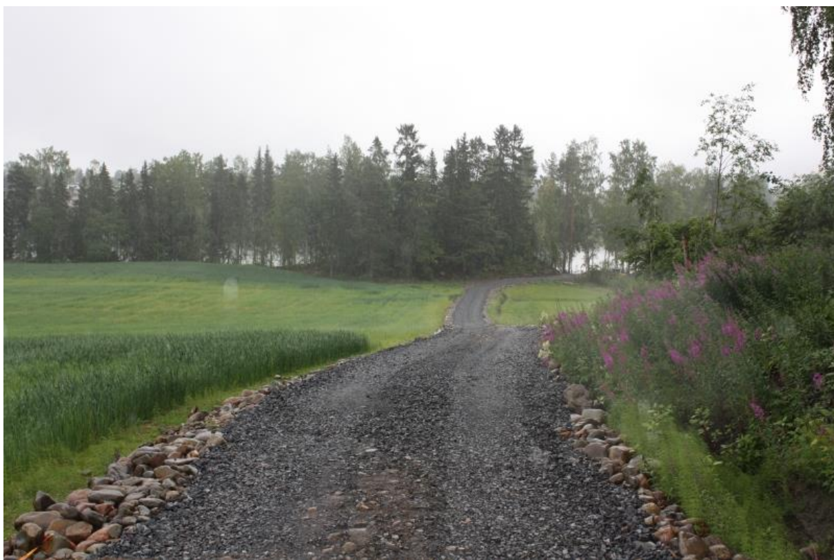
Kuva 10. Yleiskuva valmiista tiepohjasta koekaivausalueella. Kuvattu lännestä. AKDG6063:3.
