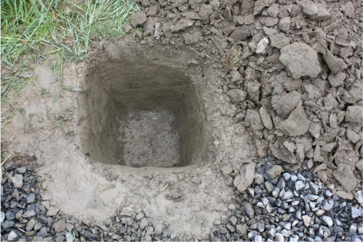
Kuva 15. Koekuoppa 3 pohjaan kaivettuna. Kuvattu etelästä. AKDG 6063:9
