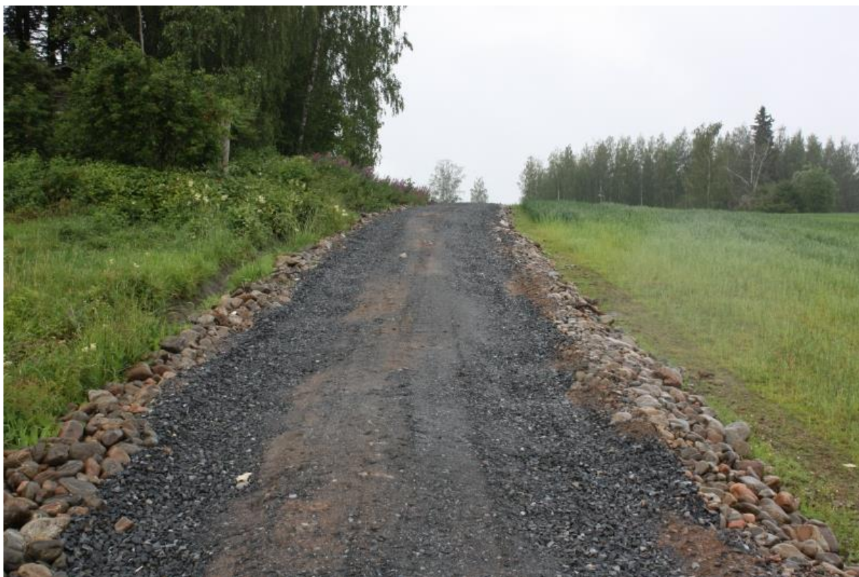
Kuva 12. Yleiskuva valmiista tiepohjasta koekaivausalueen itäpuolella. Kuvattu idästä. AKDG6063:5.
