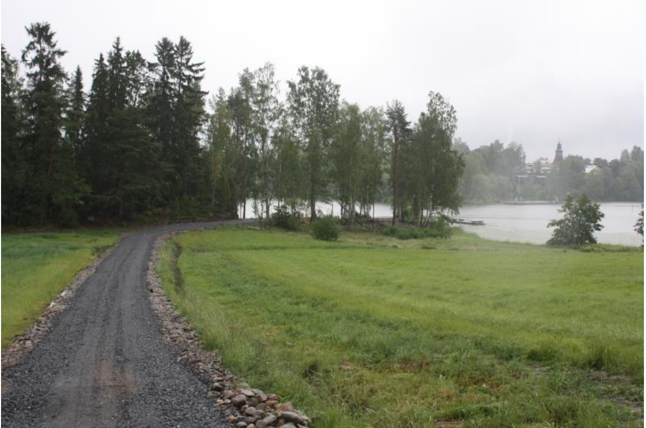
Kuva 13. Yleiskuva valmiista tiepohjasta koekaivausalueen itäpuolella. Kuvattu lännestä. AKDG6063:6
