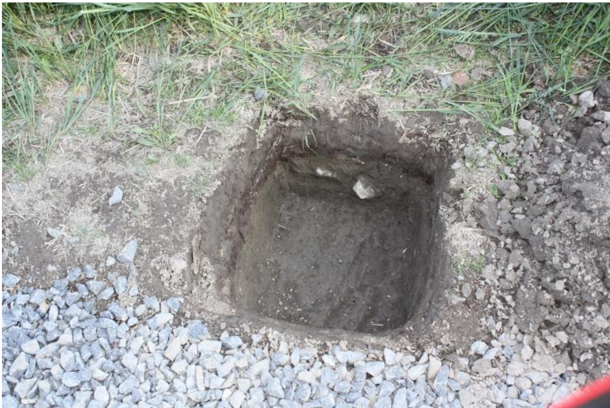
Kuva 21. Koekuoppa 15 pohjaan kaivettuna. Kuvattu etelästä. AKDG 6063:22
