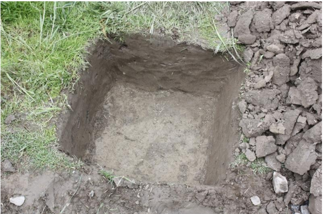
Kuva 16. Koekuoppa 4 pohjaan kaivettuna. Kuvattu etelästä. AKDG 6063:10
