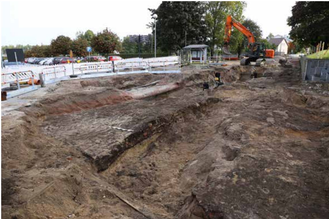
MuTu117030Dg_8. Alue 1. Eteläinen ja pohjoinen lohko esiin otettuna. Pohjoisessa M103, M108, M109 pinta. Etelässä M104 sekä osin esillä R107. / Lounaasta. Maija Helamaa 26.9.
