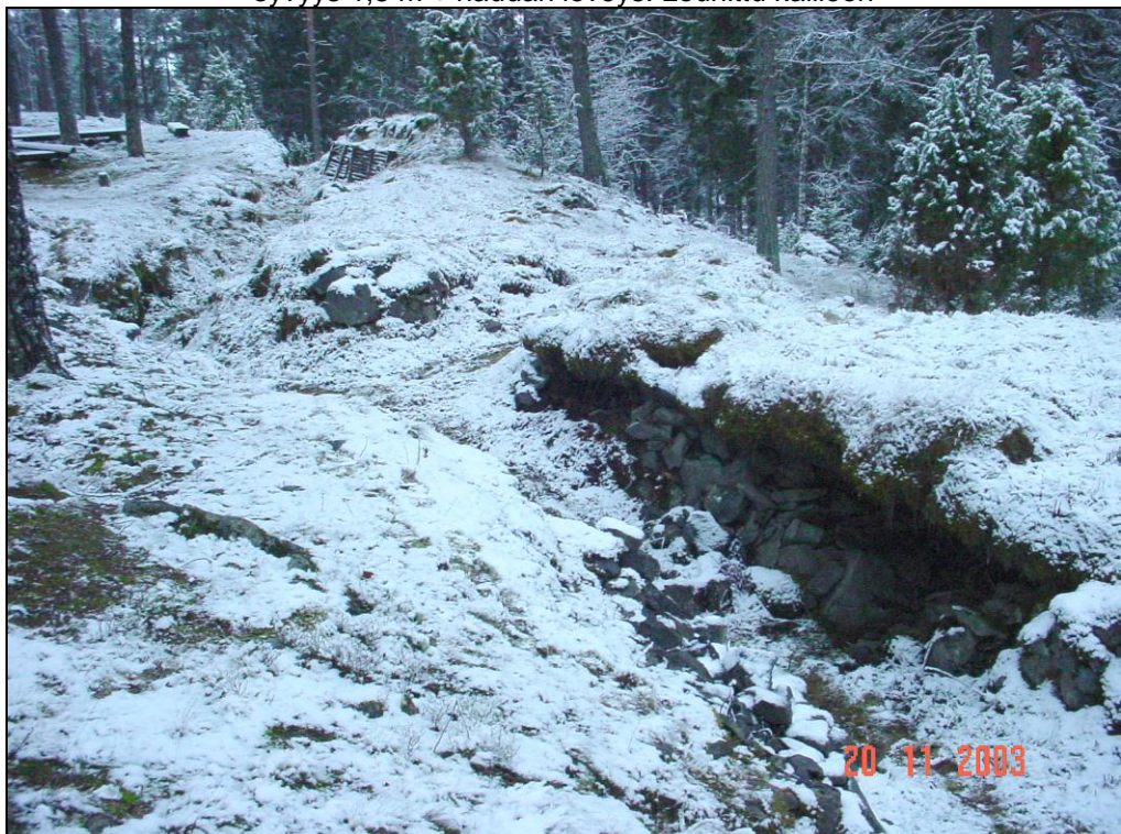
21b Katettu suoja ja katetun suojan eteläpuolinen osin entistetty pesäke, leveys 1.5 m syvyys 1,5 m + haudan leveys. Louhittu kallioon
