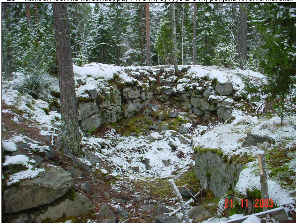
23 kallioon louhittu korsukuoppa, 7 x 8 m, syvyys 2-3 m, pohjalla kivenlohkareita.
