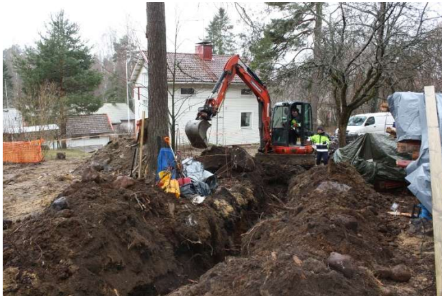
AKDG 6903:18. Koeojaa kaivetaan. Kuva: Petro Pesonen.
