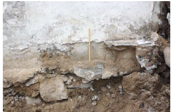
AKDG6903:12. Kellarin ja suojahuoneen lattiataso. Kuva: Petro Pesonen.
