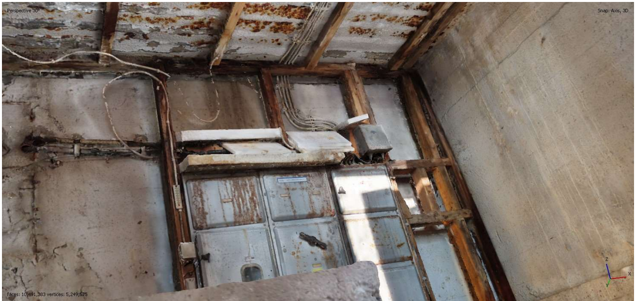
AKDG 6994:29. Näkymä läntisestä suojahuoneesta. Kuvakaappaus 3d-mallista.
