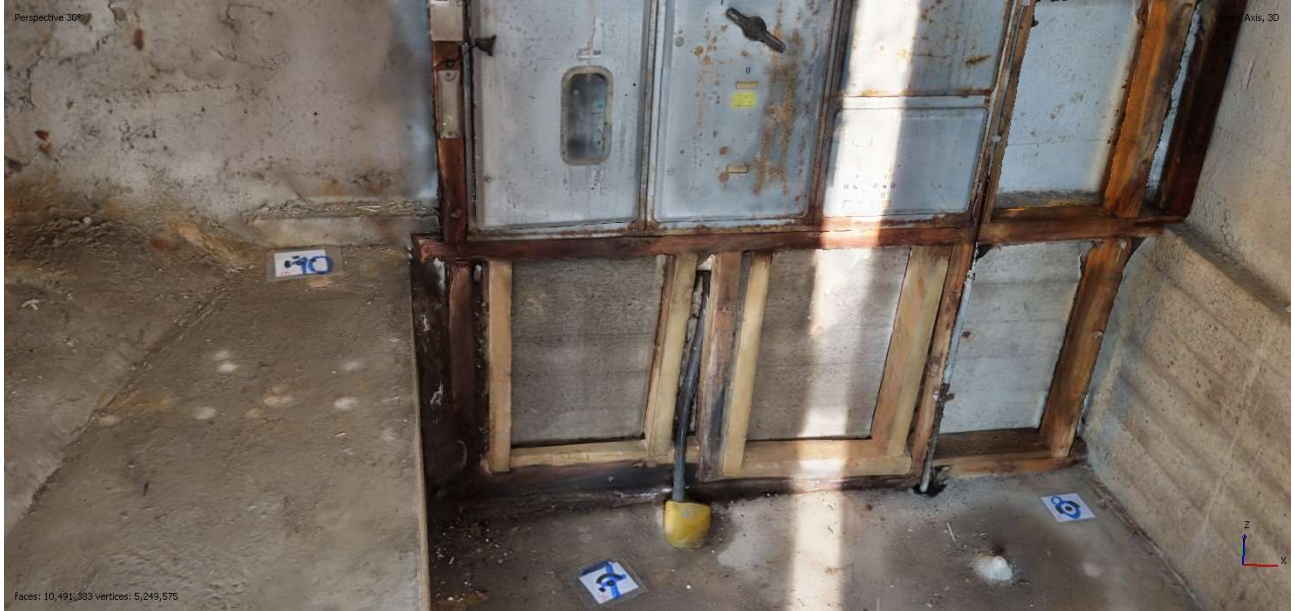
AKDG 6994:28. Näkymä läntisestä suojahuoneesta. Kuvakaappaus 3d-mallista.
