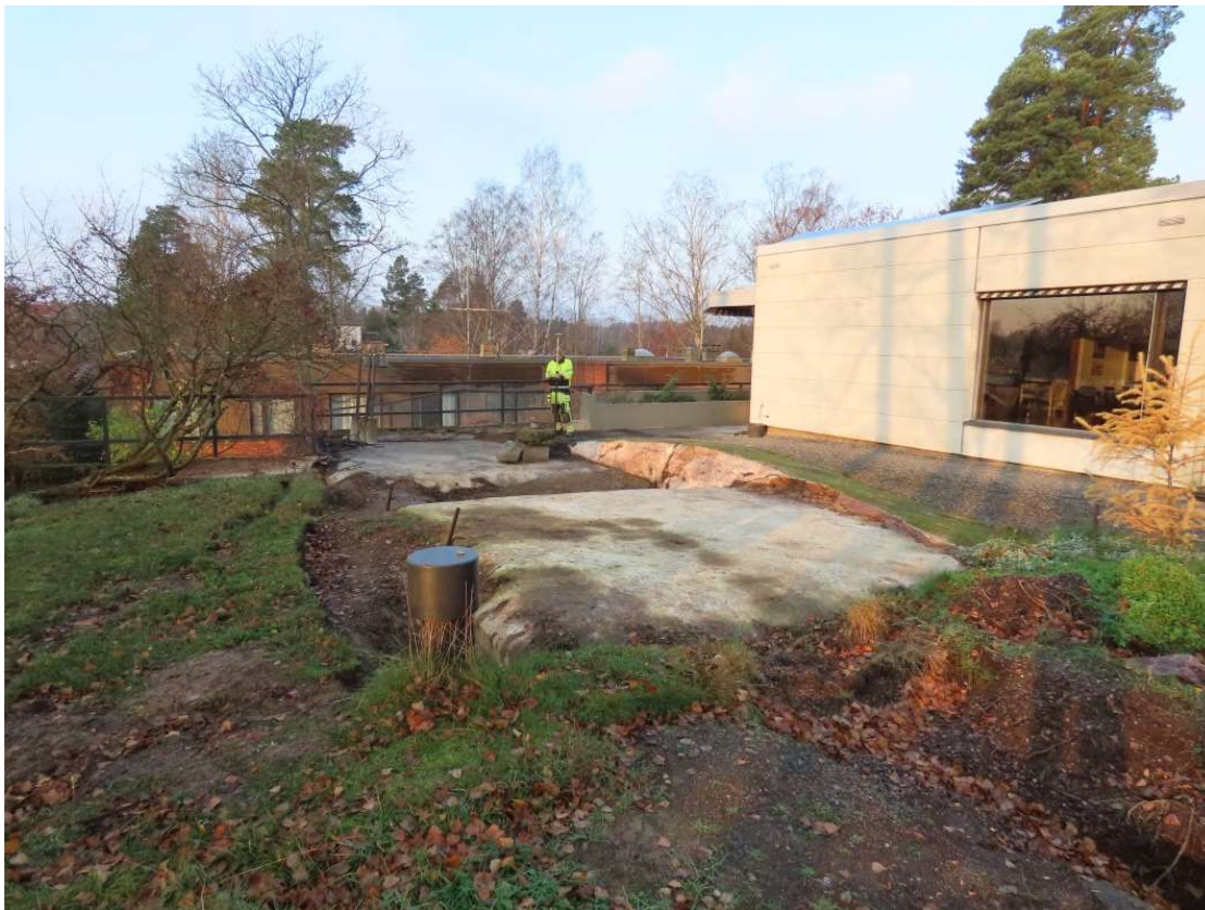
AKDG 6994:1. Yleiskuva suojahuoneiden katosta, Jan-Erik Nyman mittaamassa, kaakosta.
