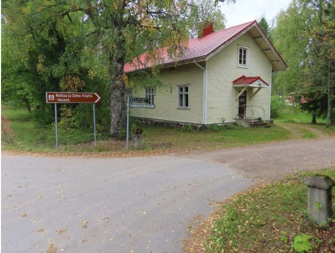
AKDG 6926:30. Vääpelin talo.
