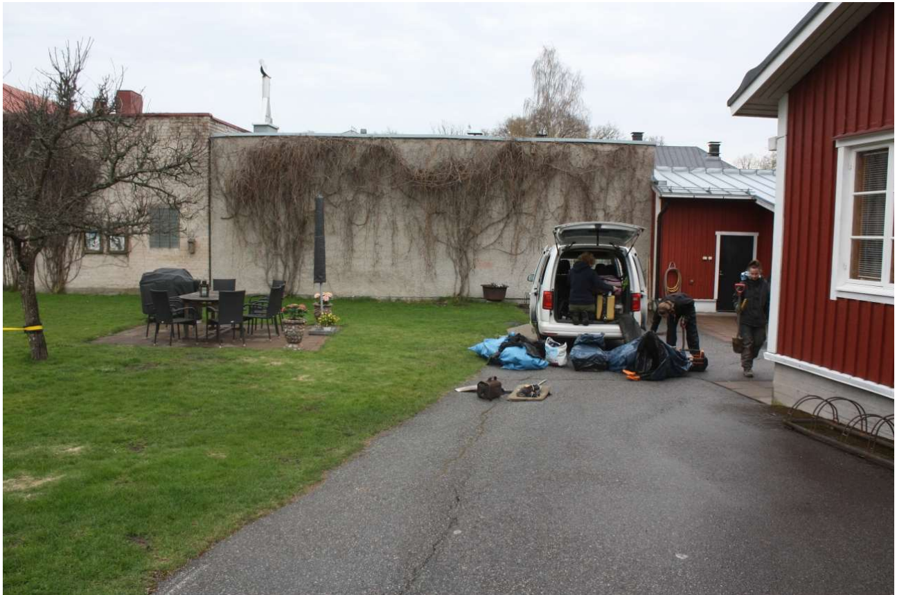
AKDG 6913:2. Kaivausta aloitellaan, lännestä.
