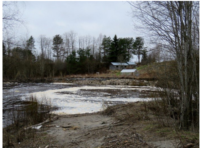
Kuva 8. Kauhavanjoen jokitörmän suojaus Jylhänkosken länsipuolella.
