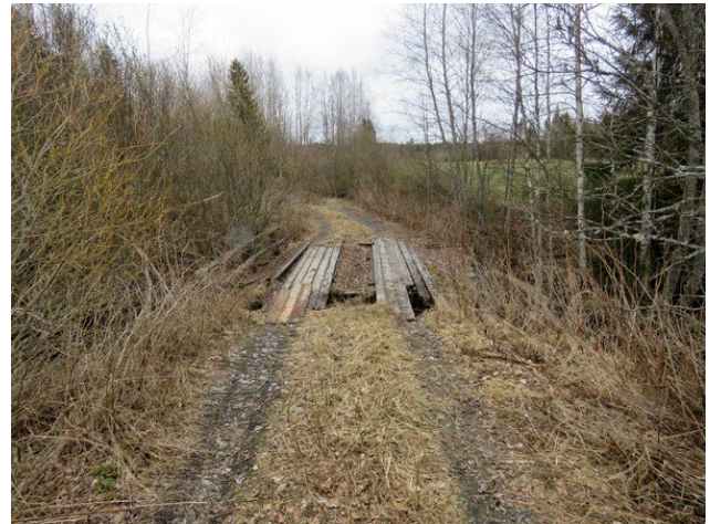
Kuva 2. Vuorenmaantie, Peräluoman silta,
