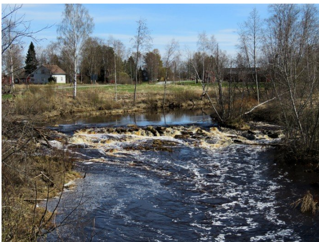
Kuvan keskellä pohjapato (1), oikealla sen yläpuolella suiste (3) ja ränni.
