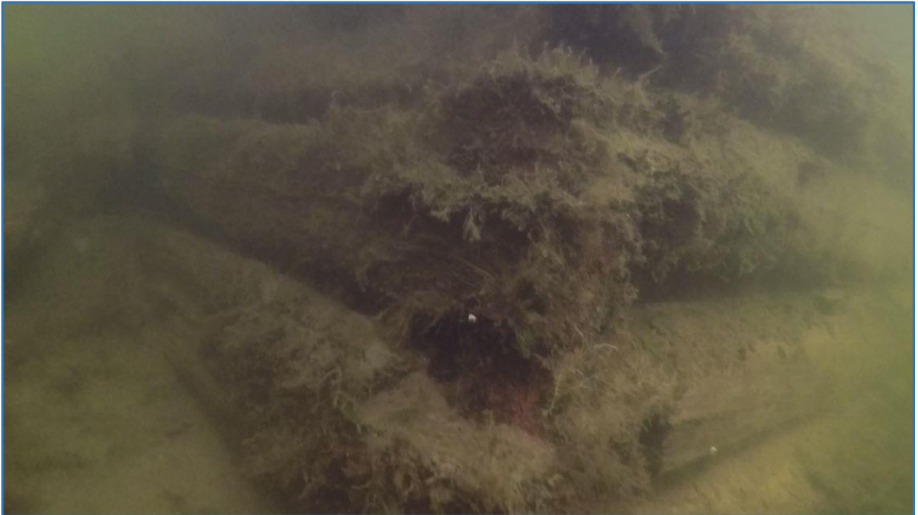
Kuva 26. Arkun kulmien salvokset ovat säilyneet ehjinä puuttuvia ylimpiä kerroksia lukuun ottamatta.
