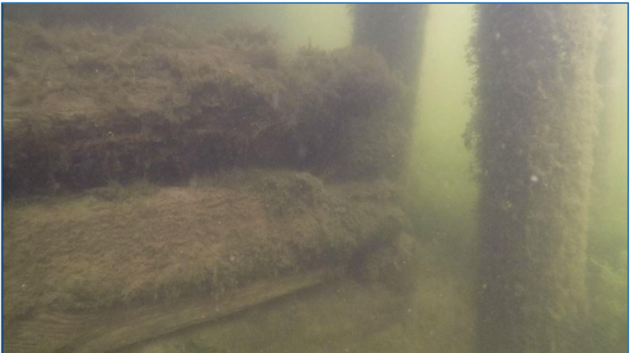
Kuva 25. Hirsiarkun kulma ja nykyistä laituria kannattelevat puiset tolpat.
