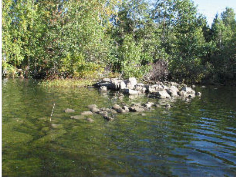
Kuva 5: Kuvassa on Jumalniemen länsipuolella sijainnutta laiturirakennelmaa. Kuva Minna Leino, Museovirasto.
