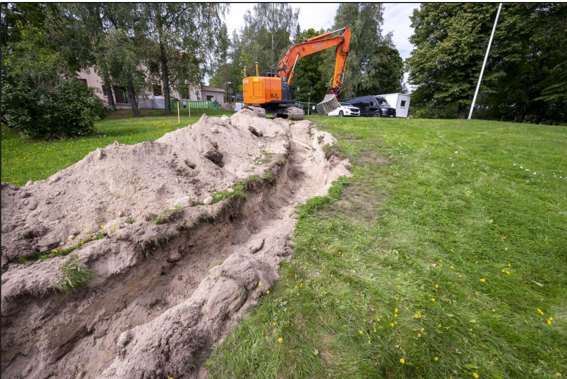
Kuva 13. Kaivannon pohjoisosa, joka yhdistyi aiempaan putkikaivantoon. Kuva idästä. (AKDG7393:9.)
