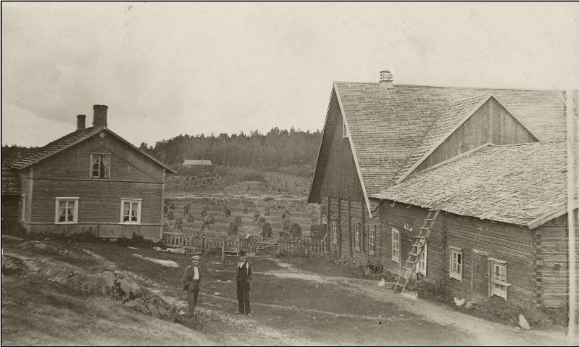
Kuva 18. Kuva Velskolan päärakennuksesta ja navetasta 1900-luvun alkupuolelta, kuvan otto ajaksi on merkitty väljästi 1900–1935. Kyseessä vaikuttaisi olevan kuitenkin vanhempi kuva kuin vuoden 1937 kuvat, sillä ainakin päärakennuksen sisäänkäyntiä ja kuistia on uusittu kuvien välillä. Päärakennus ja navetta on purettu uuden kartanorakennuksen tieltä, molemmat näkyvät vielä kuitenkin vuoden 1937 kuvissa. Löytynyt kivijalka voisi mahdollisesti olla navettarakennuksen itäpää. (Lähde Finna.fi. Espoon kaupunginmuseo, valokuva 2889:2.)
