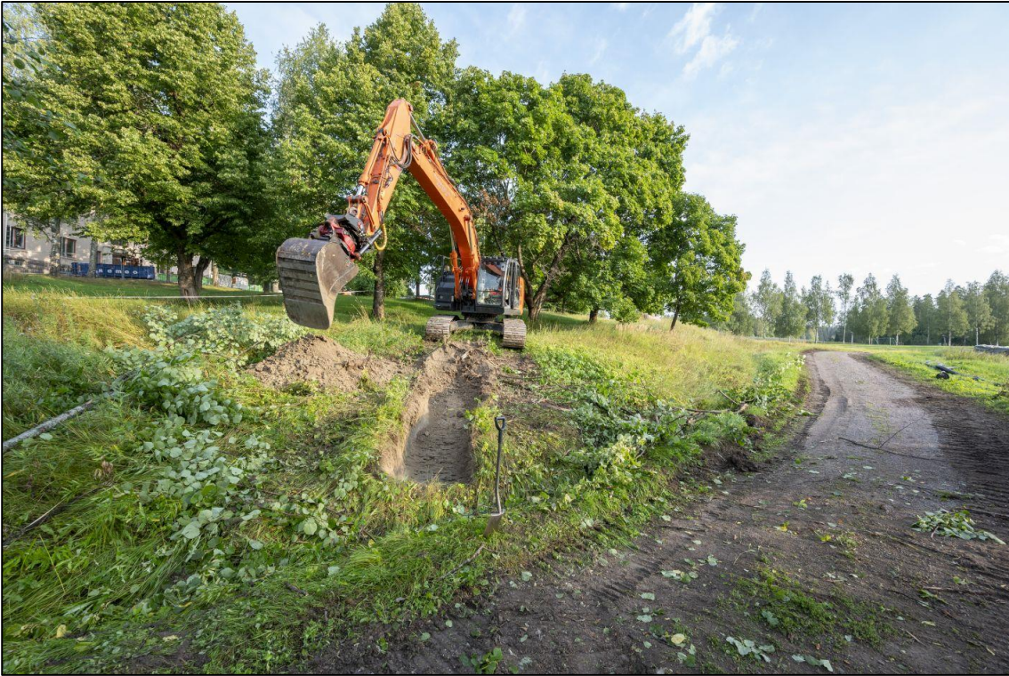
Kuva 8. Kaivutyö alkoi valvottavan putkilinjan eteläpäädästä tien vierestä. Kuva etelästä. (AKDG7393:4.)
