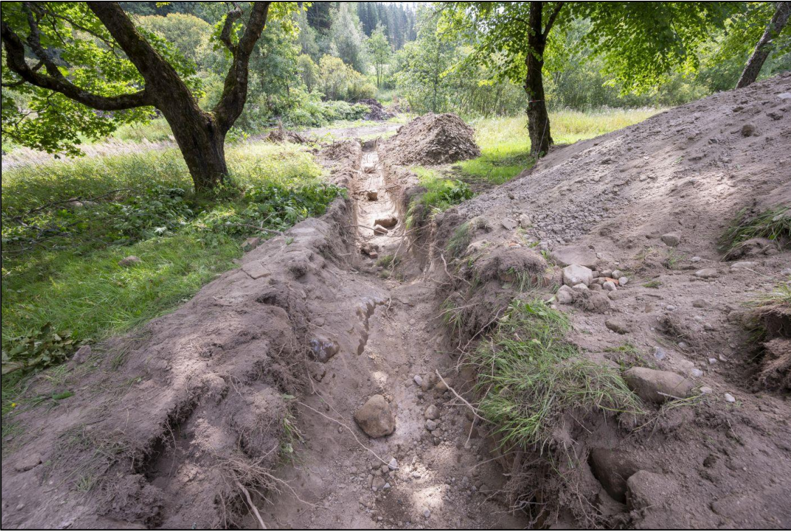
Kuva 12. Kaivannon eteläosaa. Etualalla kuvassa kalliokynnys, jonka pohjoispuolella maaperä vaihtui hiekaksi ja kynnyksen alapuolella on savea. Kuvassa näkyy kaivantoon kaivuvaiheessa vierineitä kiviä, jotka poistetaan putken asennusvaiheessa. Kuva pohjoisesta. (AKDG7393:10.)
