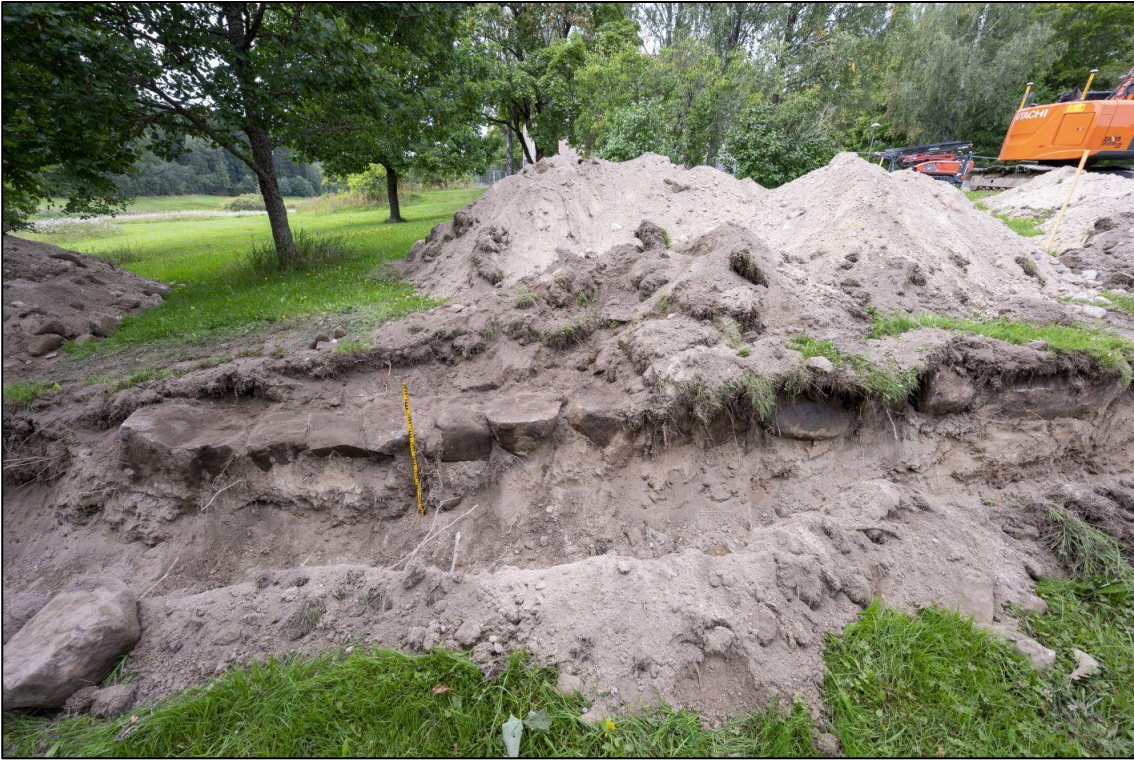
Kuva 10. Kaivutyössä paljastunut noin 7 metriä pitkä kivijalka, joka voitiin kiertää sen sivuitse vahingoittamatta rakennetta. Kivijalan pinnasta paljastettiin vain eteläosa ja sen pohjoisosa erottuu kaivannon reunasta. Kuva idästä. (AKDG7393:5.)
