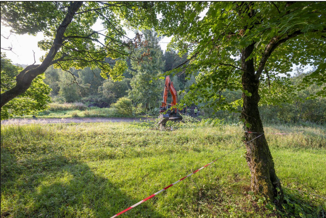
Kuva 7. Kaivinkone raivaa vesakon tien vierestä, mistä kaivutyö alkoi. Kuva pohjoisesta. (AKDG7393:2.)
