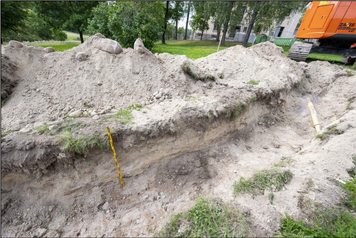
Kuva 16. Kaivannon pohjoispää, kaivanto yhdistyi vanhaan putkikaivantoon kuvan oikeassa reunassa. Kuva kaakosta. (AKDG7393:14)
