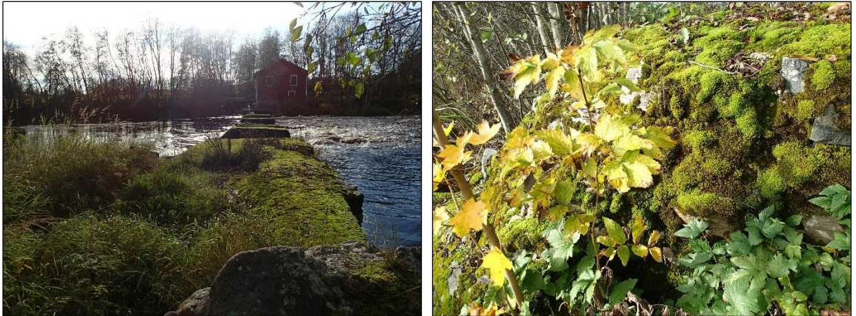
Vasemmalla betonirakenteista myllypatoa kuvattuna kohti vanhaa myllyrakennusta, oikealla rannalla kivistä tehdyn rakenteenteen jääne.
