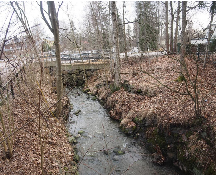
AKDG7416:2. Myllyn kivityksi uomaksi tulkittu kiveys Haaganpuron länsirannalla Papinmäentien sillan pohjoispuolella. Kiveys erottuu kuvassa uoman oikeanpuoleisella reunalla.
