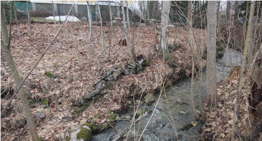
AKDG7416:1. Myllyn kivityksi uomaksi tulkittu kiveys Haaganpuron länsirannalla. Vasemmalla etualalla kiveys katkeaa tavalla, joka viittaa kiveyksen vaurioitumiseen tai romahtamiseen. Pohjoiseen kiveys jatkuu vielä sen läpi kasvavasta koivusta edemmäs. Kuvattu kohti luodetta. Kuva: T. Mökkönen.
