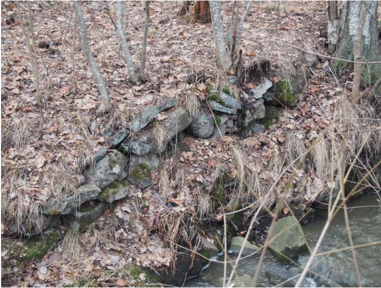
AKDG7416:3. Kiveys koostuu 2–3 kiviterrasta ja sillä on korkeutta 50–60 cm. Suurin osa rakenteen kivistä on pyöreitä, joten kyseessä ei ole 1900-luvun alun kallion räjäytyksessä syntynyt kiviaines. Kuva: T. Mökkönen.
