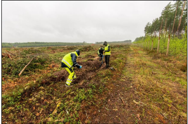
Kuva 25. Koeojaa kaivetaan sateessa. (AKDG6956:2)
