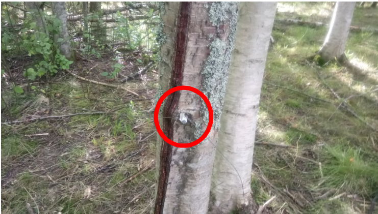
Kuva 15: Puihin kiinnitettyjä vanhoja sähköaitoja lohkolla 3. (Taina Raudaskoski 2017.)
