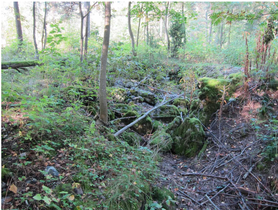
Linnoitteen länsiosassa ulkoilupolun pohjoispuolella sijaitseva räjäytetty suojahuone kasvillisuuden valtaamana. Kuvaussuunta länteen.
