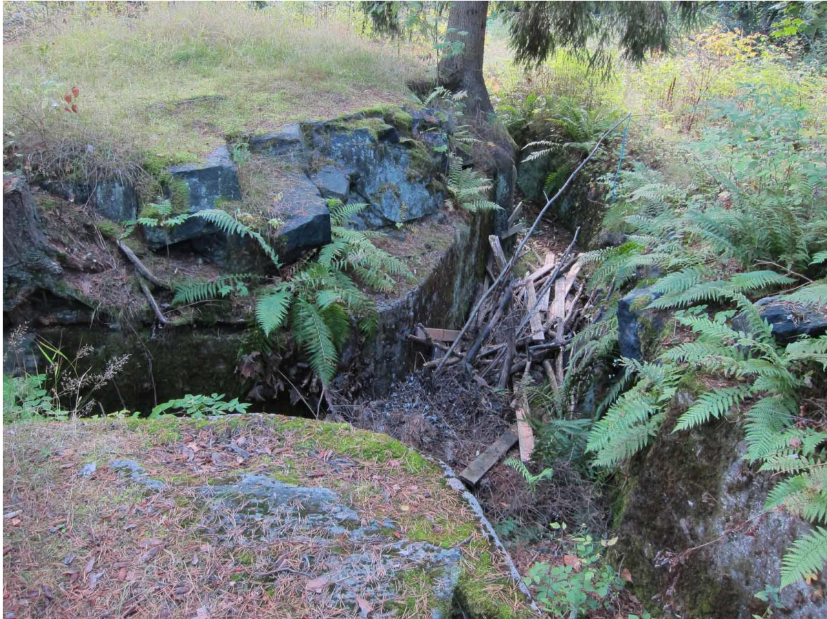
Linnoitteen pohjoislaidan yhdyshautaa etelään kuvattuna. Hautaan on kertynyt puujätettä.
