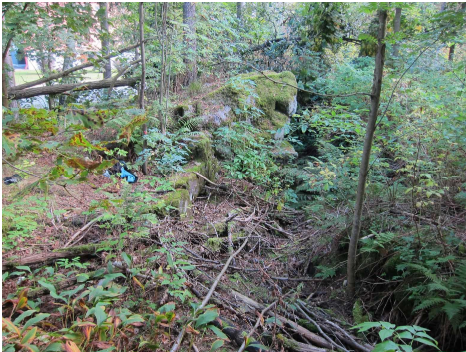
Kuva on kohteen koillisosasta kuvaussuuntana eteläkaakko. Yhdyshaudan pohjalla lojuu puujätettä ja sivummalla joku vaatekappale. Kohteen siistimisen alkuvaiheessa voisi keskittyä vain roskan ja maatuvan puujätteen putsamiseen linnoitteen rakenteista. Kuvat: Heini Hämäläinen/HKM 14.9.2015.
