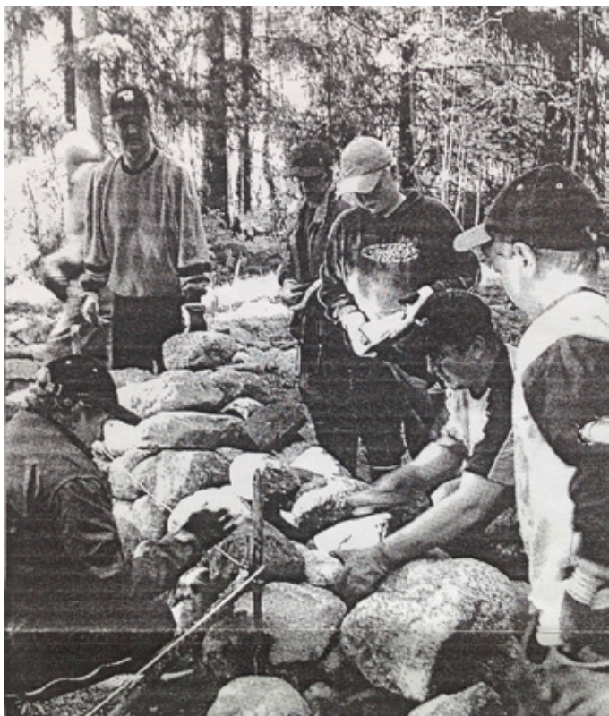
Lahdenhovin hautausmaan kiviaita rakenteilla vuonna 2004. (Pitäjän uutiset)
