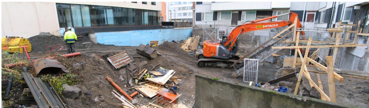
Torikatu 12:n työmaa kuvattuna tontin länsikulmasta. 20.10.2009/J. Enqvist, MV/RHO.
