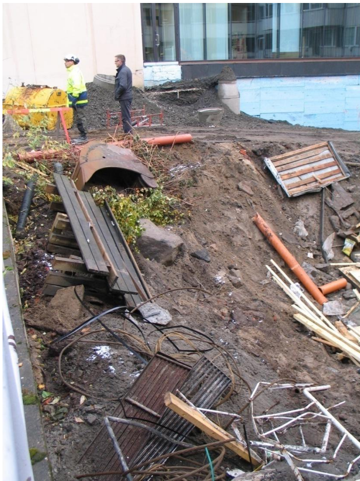
Kaivamaton ajoluiska Torikatu 12:n työmaalla kuvattuna etelästä. 20.10.2009/J. Enqvist, MVRHO.
