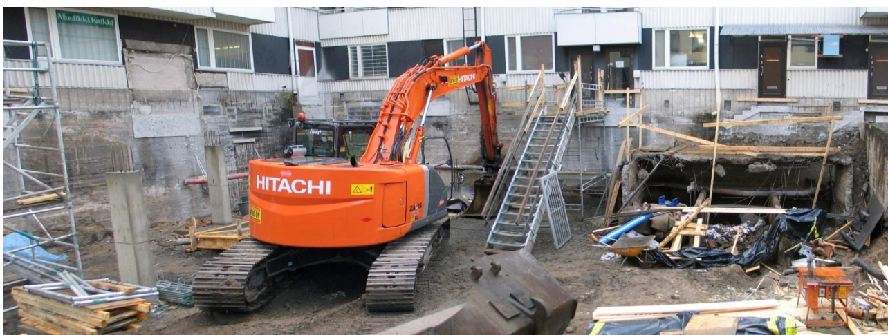
Torikatu 12:n työmaa kuvattuna tontin pohjoislaidalta. 20.10.2009/J. Enqvist, MV/RHO.
