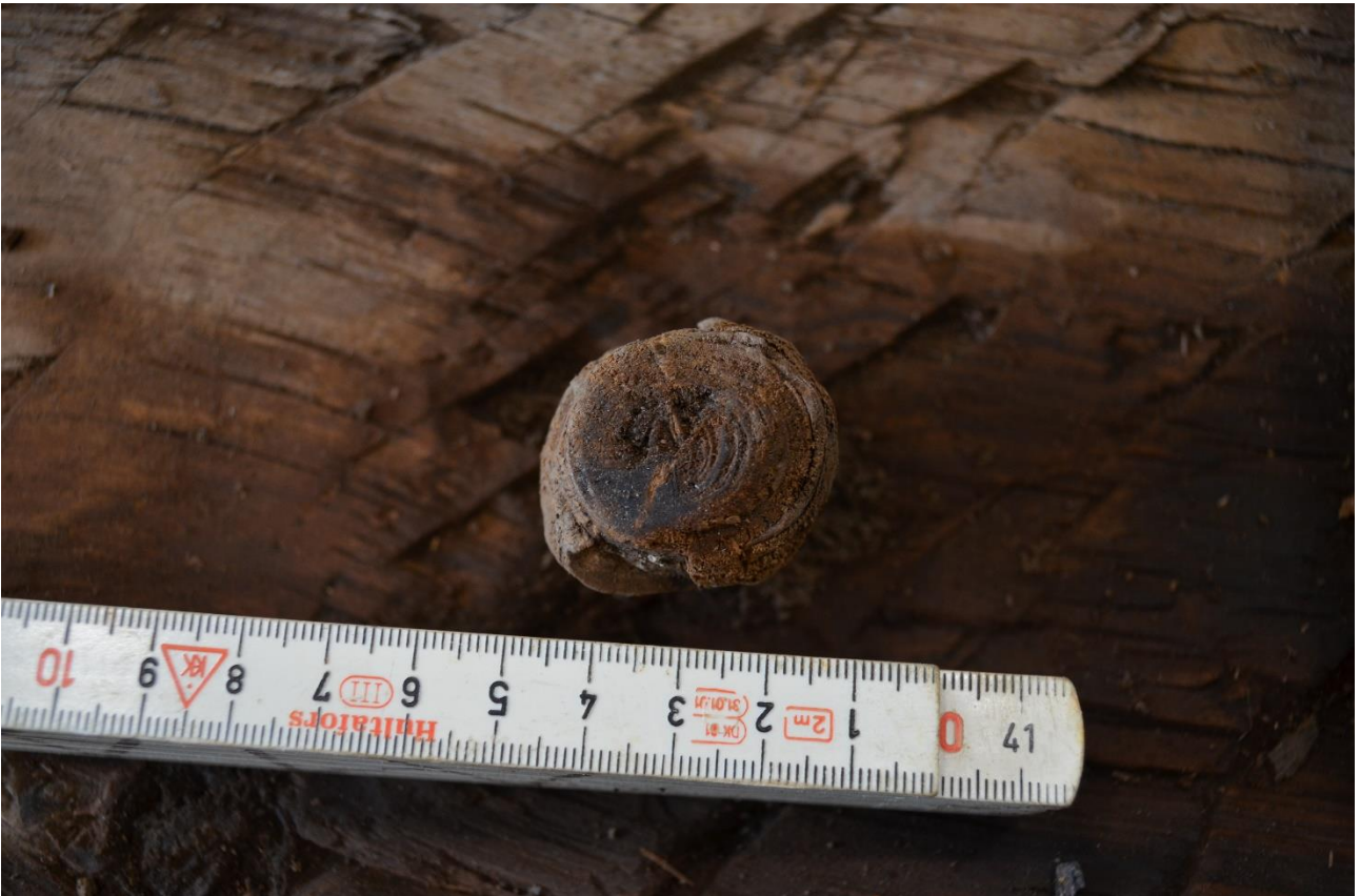
Liite 2. Puutappi veden poistoon, ruuhen pohjassa (kuvaaja: Irissou Y.).
