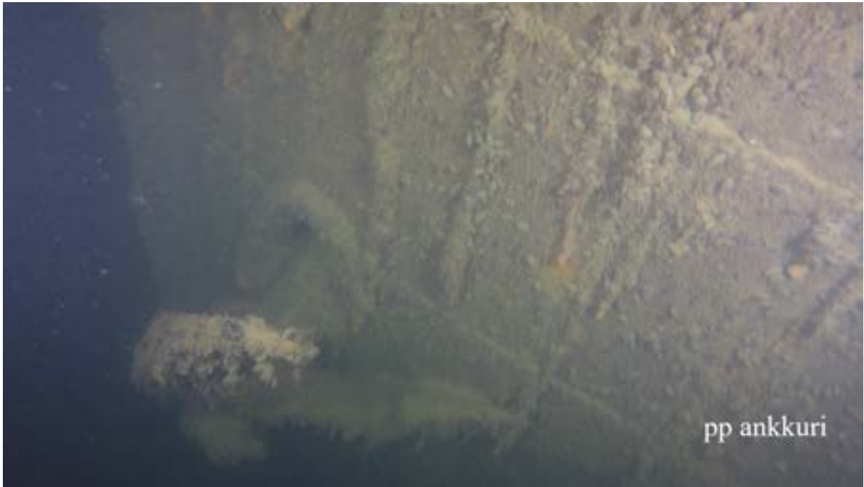
sähköpääkeskus korsteenin juurella
