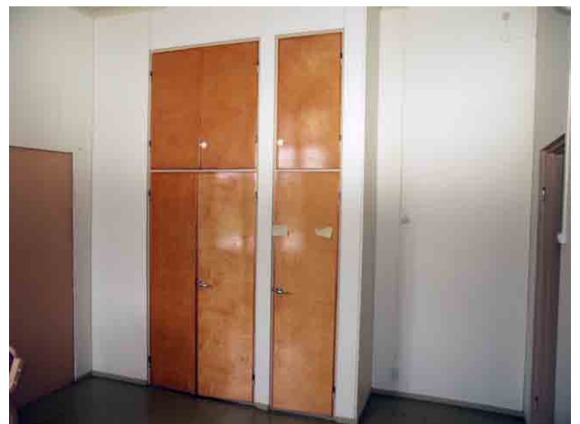
Lakattuja vaneriovia 1950-luvun korjauksessa tehdyissä komeroissa.
