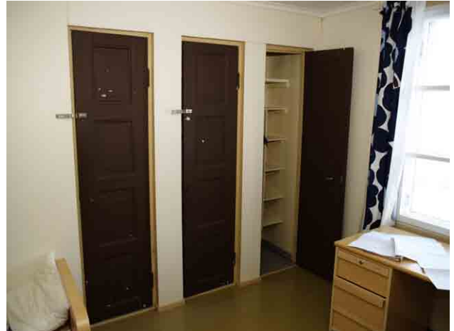
Majoitushuoneiden alkuperäisiä komeroseiniä.
