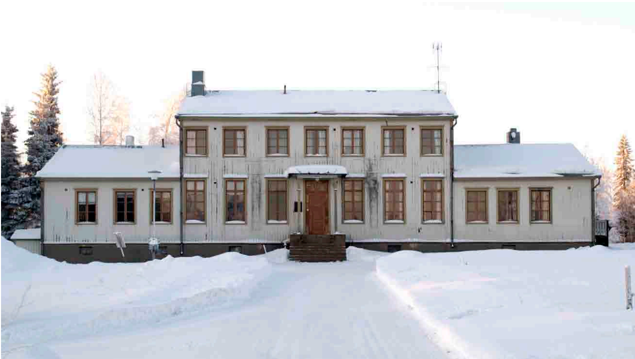
Impilinnan itään oleva pääjulkisivu talvella 2012.
