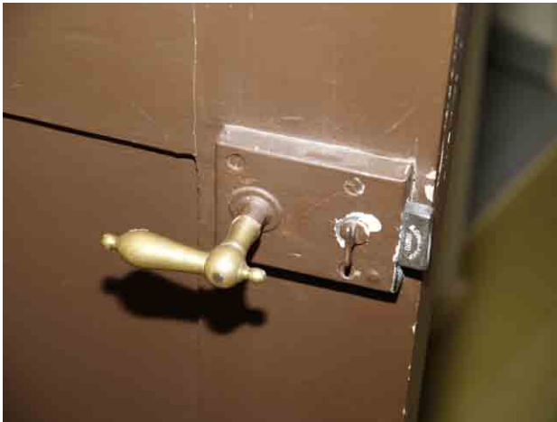
Komeron ovesta oleva alkuperäinen lukko 1. kerroksessa.
