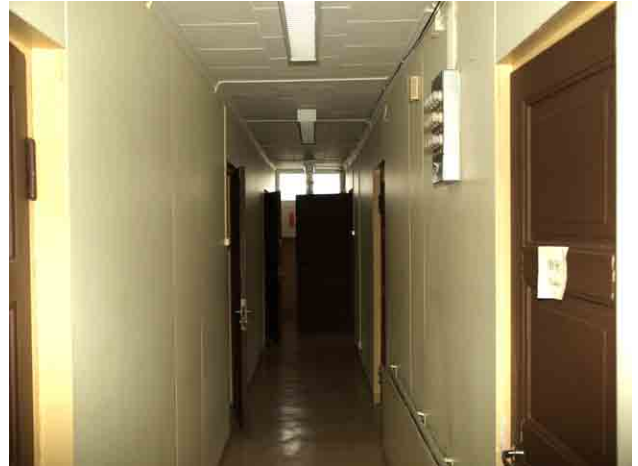
Yläkerran kapea käytävä, johon asuinhuoneiden ovet aukeavat. Ovet ovat alkuperäisiä, mutta pintaverhouksia on uusittu eri aikoina.
