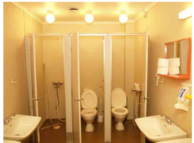
Yläkerran pesuhuone WC- ja suihkukoppeineen
