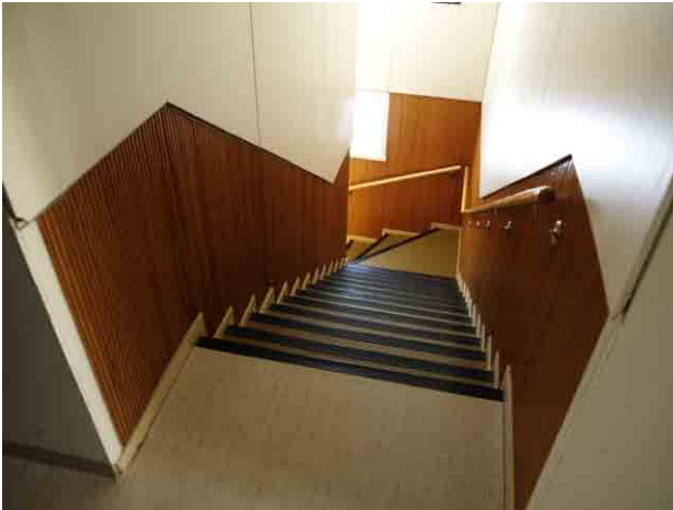
Porras nähtynä yläkerran käytävästä. Alunperin porras nähtävästi oli avarampi. Sormipaneeliverhoukset on 1950-luvun korjauksesta.
