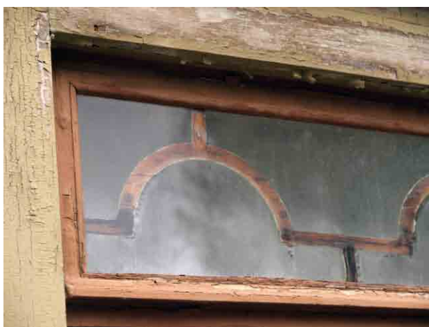
Ulko-ovien yläikkunoiden alkuperäisiä koristeaiheita. Oikealla olevassa pohjoispään ikkunassa on lasi ilmeisesti uusittu yhtenäiseksi, jolloin ulkopuolen listat on samalla poistettu.
