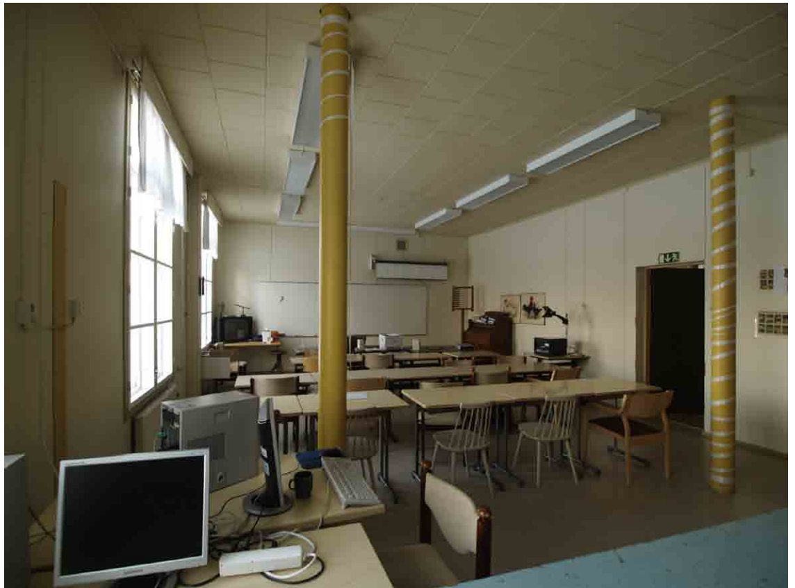
Nykyinen luokkatila, joka vuoden 1957 korjauksessa muodostettiin yhdistämällä kaksi aiempaa huonetilaa. Katon Halltex-levyt ovat todennäköisesti peräisin tästä korjausvaiheesta. Lastulevyt seinissä ja lattioiden muovimatot ovat myöhemmistä korjauksista. Ikkunat ja ovet on uusittu.
