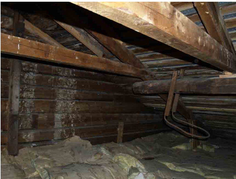
Ylemmän ullakon kattorakenteita ja lasivillaeristeitä.
