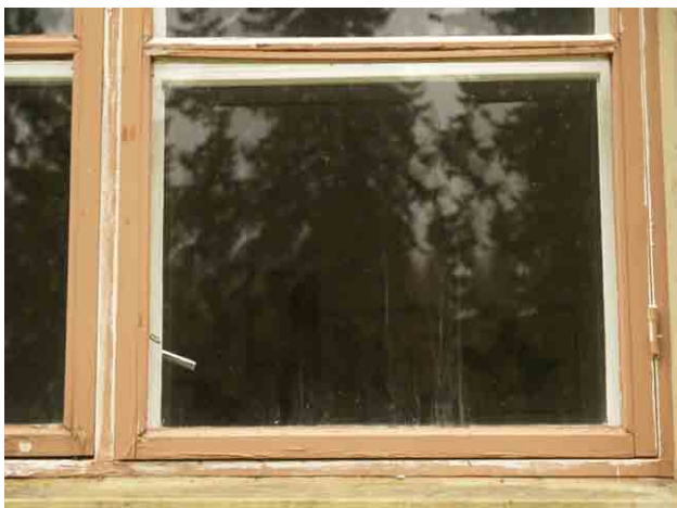
1970-luvun ikkuna lähikuvassa. Lasien kiinnitykseen on käytetty puulistoja, kun aiemmin käytettiin kittikiinitystä.
