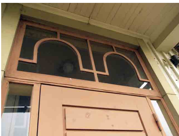
Ulko-ovien yläikkunoiden alkuperäisiä koristeaiheita. Oikealla olevassa pohjoispään ikkunassa on lasi ilmeisesti uusittu yhtenäiseksi, jolloin ulkopuolen listat on samalla poistettu.
