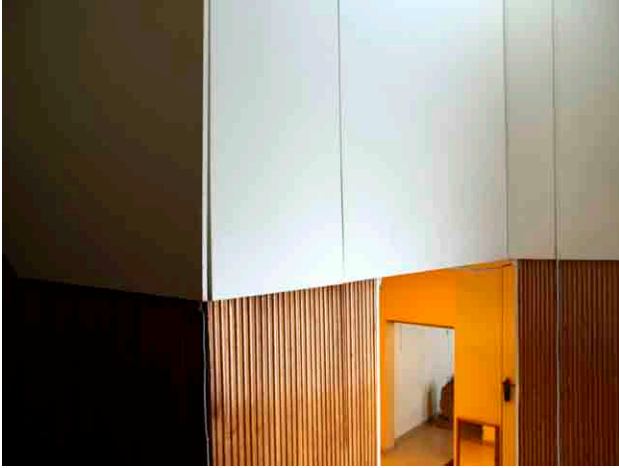
Portaan aukossa panelointi peittyy yläosaltaan myöhemmään lastulevyverhoukseen.
