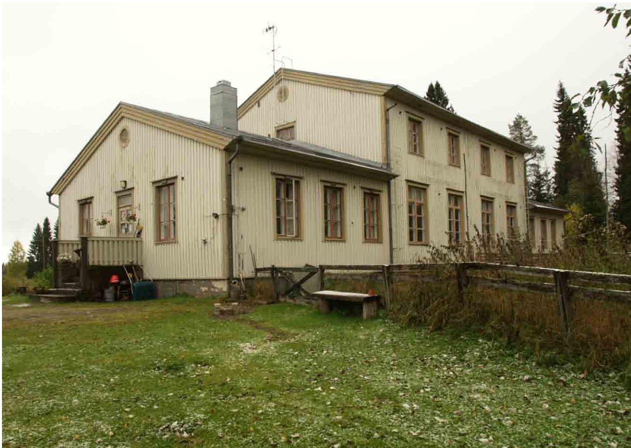
Rakennuksen pohjoispääty ja länsisivu syksyllä 2009.
