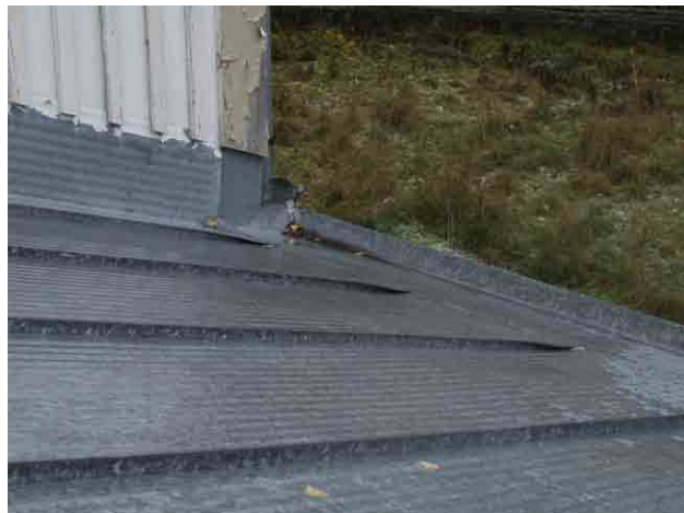
Rakennuksessa oli jo alkujaan peltikatto. Kate uusittiin 1970-luvun peruskorjauksessa.
