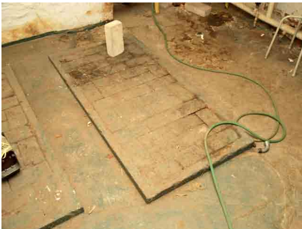
Keskuslämmitys asennettiin rakennukseen 1950-luvulla. Kellarin lämmönjakohuoneessa on vielä nähtävissä kahden kattilan tiiliperustukset ja keskuslämmityspiipun valurautainen nuohousluukku.
