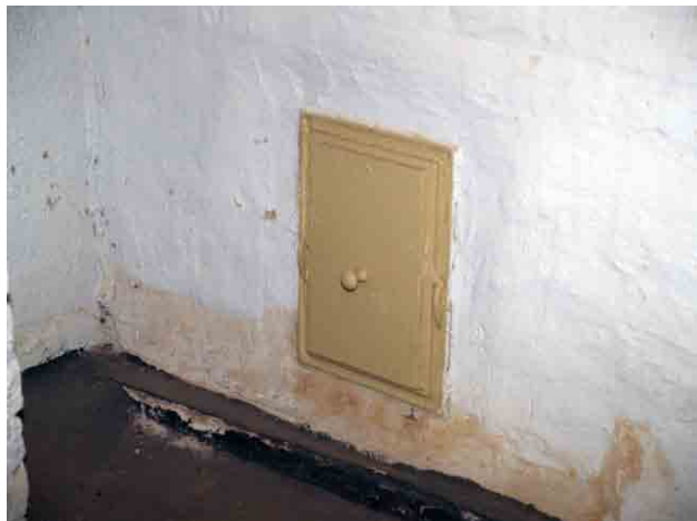
Keskuslämmitys asennettiin rakennukseen 1950-luvulla. Kellarin lämmönjakohuoneessa on vielä nähtävissä kahden kattilan tiiliperustukset ja keskuslämmityspiipun valurautainen nuohousluukku.
