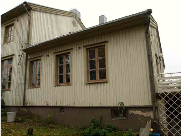
Viistoon linjaan koteloidut räystäät olivat jonkin verran käytetty tyylipiirre 1920-30-luvuilla. Vasemmalla Impilinnan räystäätä, oikealla Elias Paalasan 1930-luvun tyypipiirustuksilla Varkauteen rakennettu pientalo.
