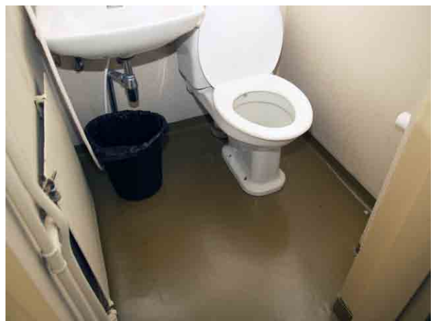
1. kerroksen käytävässä olevan WC:n istuin on 1950-luvulla käytettyä tyyppiä.
