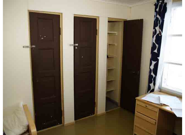
Toisen kerroksen asuinhuoneiden komeronovet ovat alkuperäisiä.
