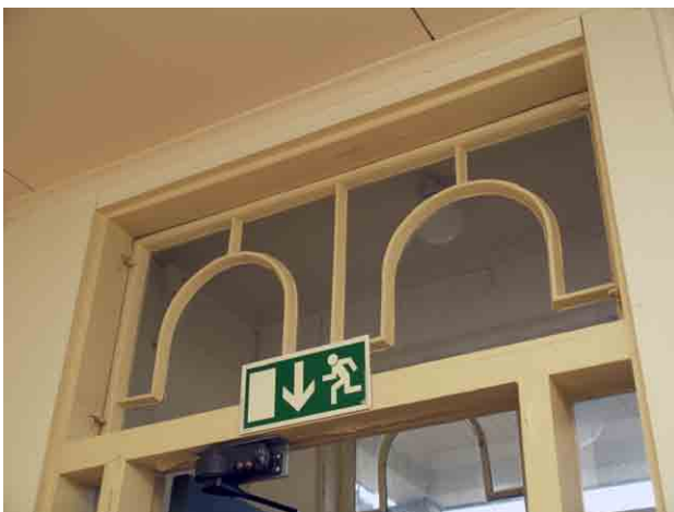
Pääsisäänkäynnin tuulikaapin oven alkuperäinen yläikkuna.
