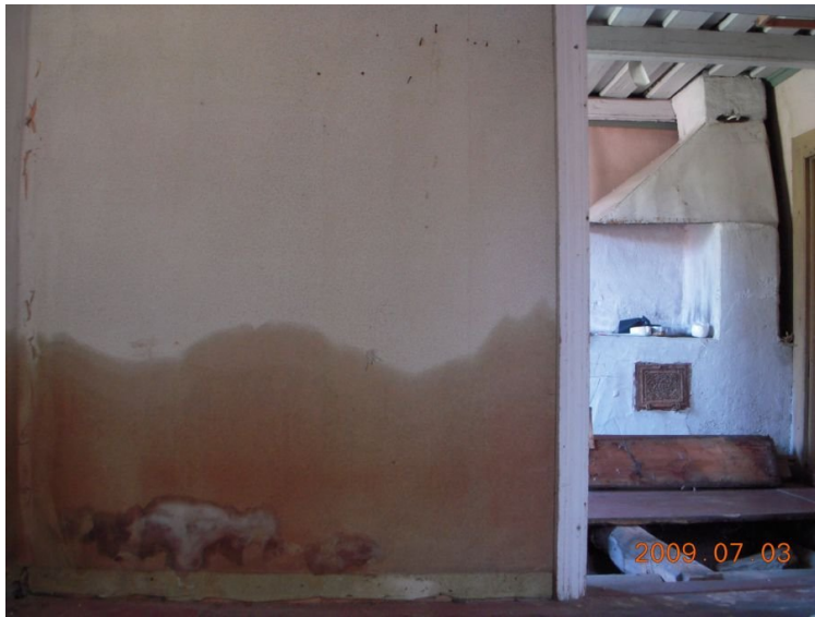
1. Kamarin seinä ja tapetoidun pinkopahvin öljystä tummunut alue.
