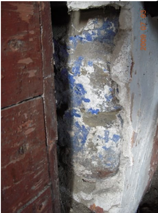
Kuva 4. Uunin vanhaa koboltin sinistä pintakäsittelyä.
