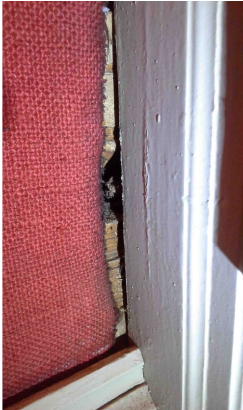
Kuva 70. Lista kiinnitettiin hirsipintaan
