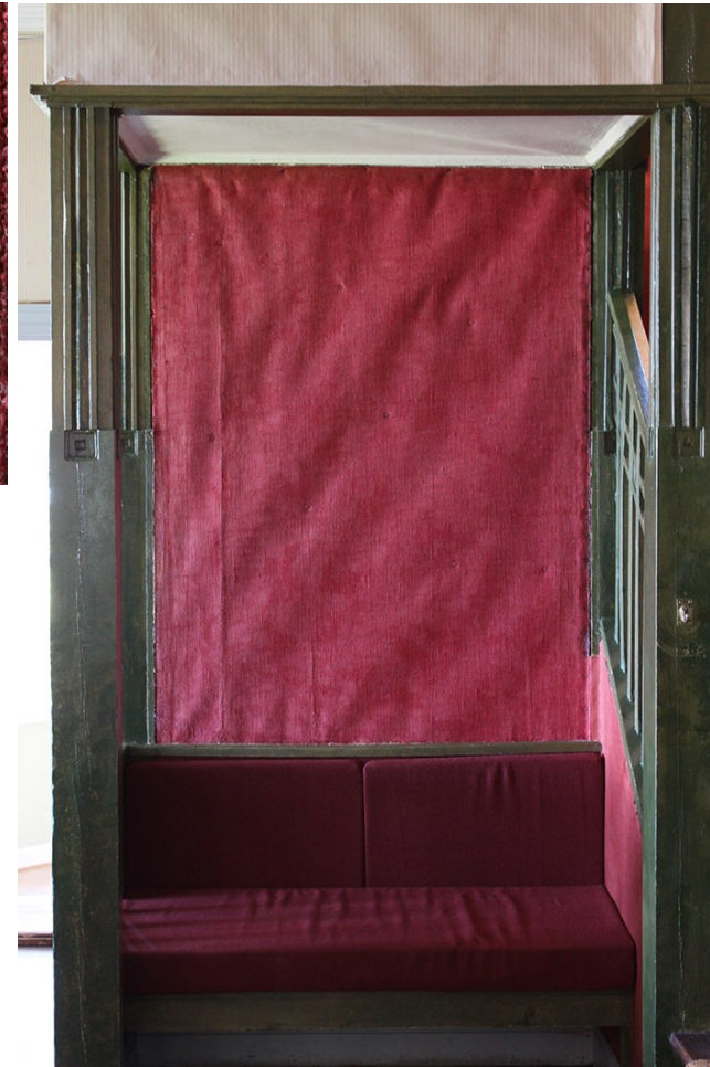
Kuva 36. Seinä kankaan esiinoton ja puuosien retusoinnin jälkeen
