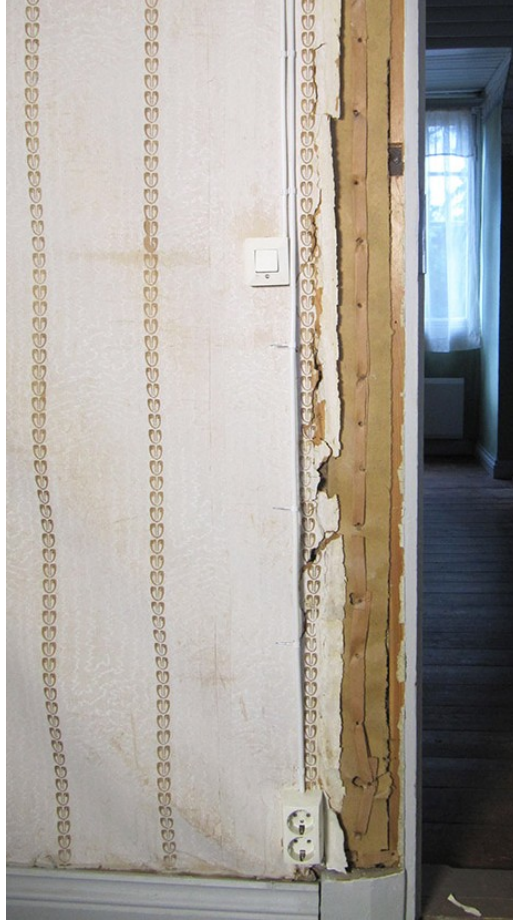
Kuva 58. Ovilista irroitettiin ja tapettireunasuoristettiin listan alle
