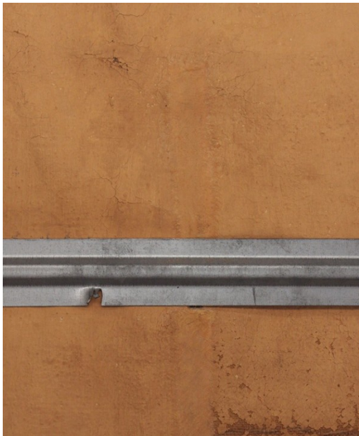
Kuvat 15.-18. Seinäpintojen reikiä ennen ja jälkeen paikkauksen ja retusoinnin.
