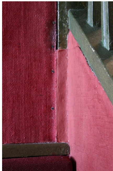
Kuva 35. Valkoiseksi maalattu osa kangasta retusoiitiin punaiseksi värjättyllä japaninpaperilla
