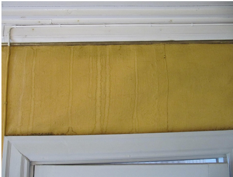
Kuvat 7.-10. Kosteusvaurioita ennen ja jälkeen retusoinnin
