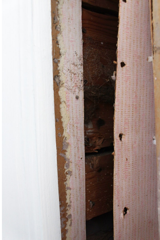
Kuva 41. Tapettireunan alla näkyy, että pahvi on jo aiemmin viilletty irti seinästä niin, että seinän reunoille on jätetty suikaleet pahvia
