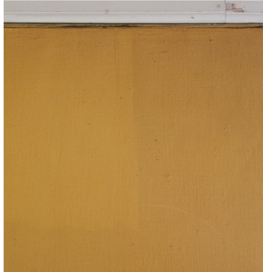
Kuva 6. Puhdistusraja seinäpinnassa
