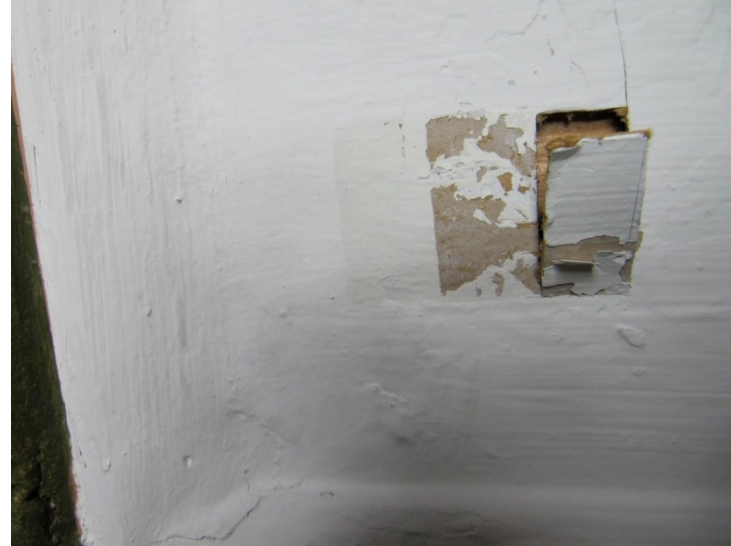
Kuva 37. Syvennyksen katon kerrokset
