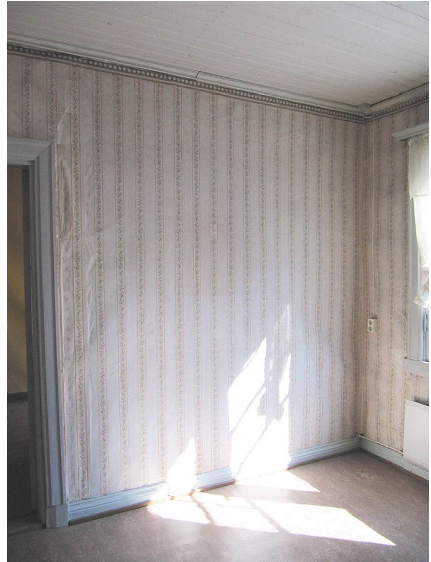
Kuva 52. Suoristettu pahvi ja konservoitu seinäpinta
