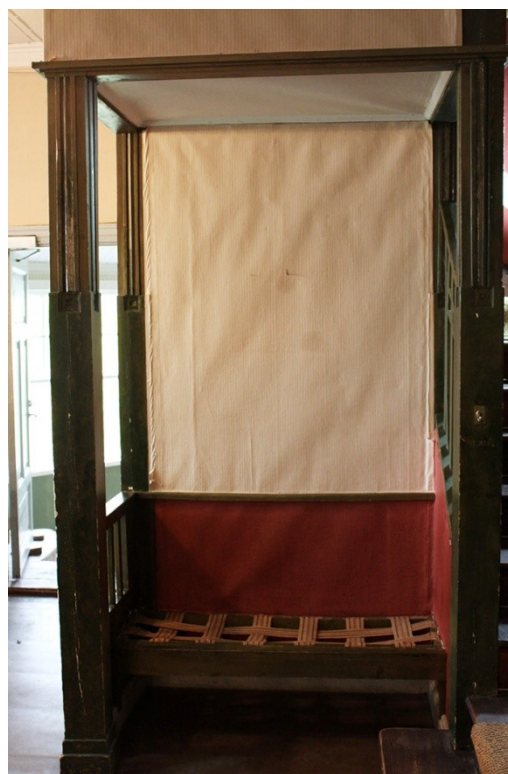
Kuva 31. Sohvasyvennyksen seinä ennen esiinottoa
