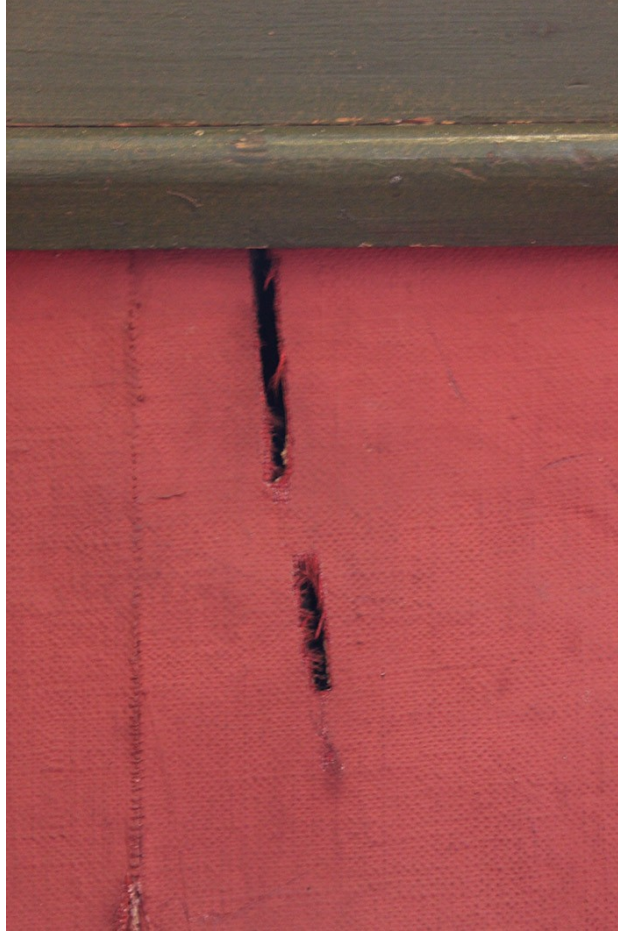
Kuvat 15.-18. Seinäpintojen reikiä ennen ja jälkeen paikkauksen ja retusoinnin.
