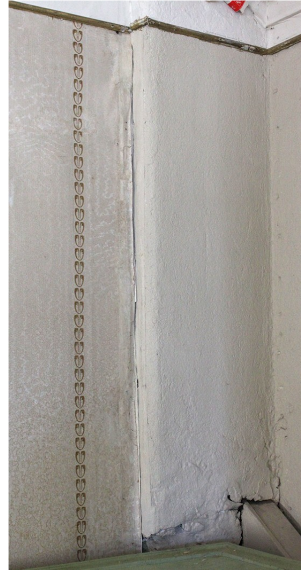
Kuva 62. Muurin reunus kiinnitettynä, paikattuna ja retusoituna
