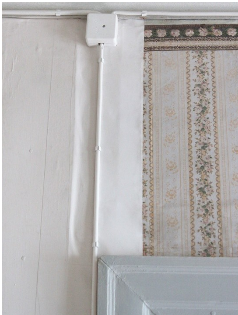
Kuva 46. (vas.ylä) Pahvin siirrosta aiheutunut rako
