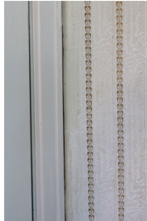
Kuva 56. Ovilistasta irroitettu tapettireuna
