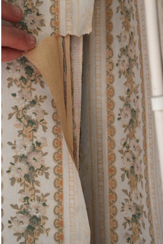
Kuva 42. Kulma viillettiin auki tapettisauman reunan alta
