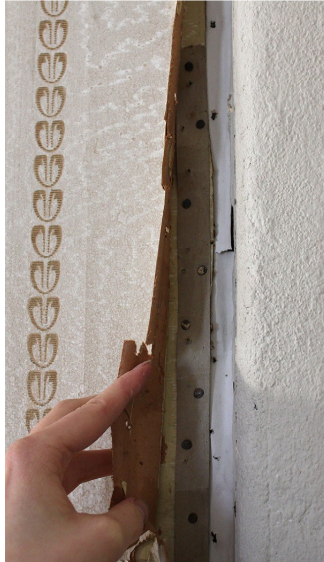
Kuva 61. Pahvin reuna kiinnitettiin uudelleen nupeilla tapetin reunan alta
