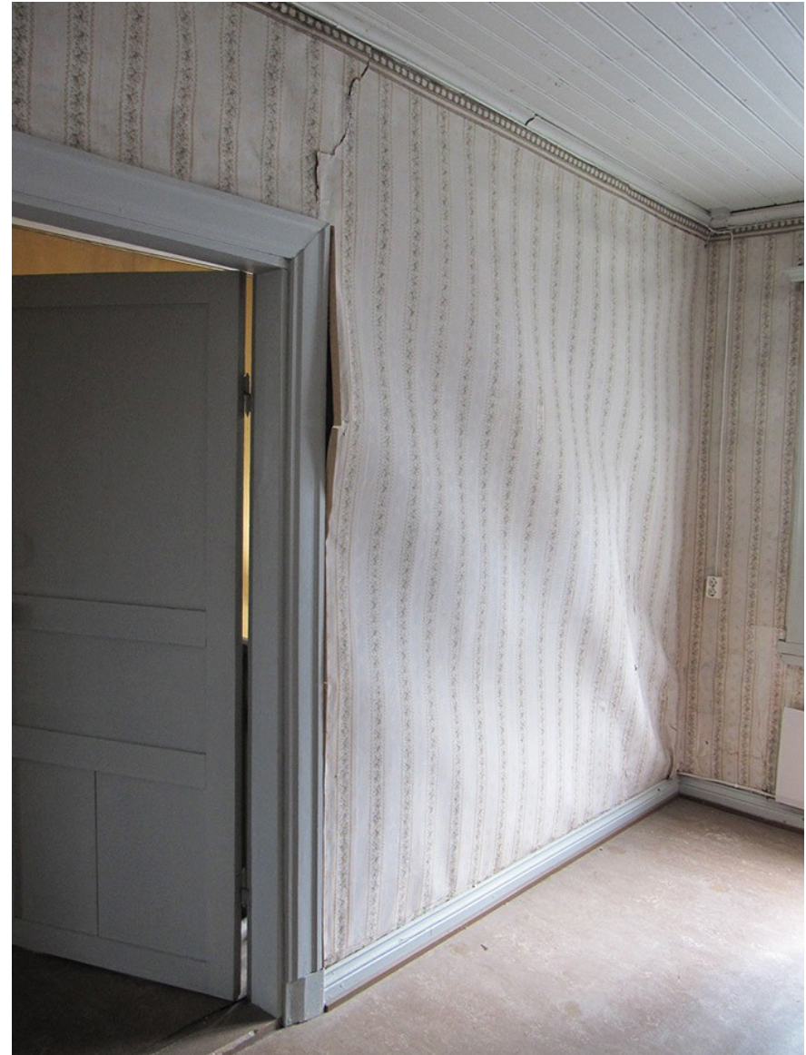
Kuva 39. Ruusukammarin kupruileva pinkopahvi
