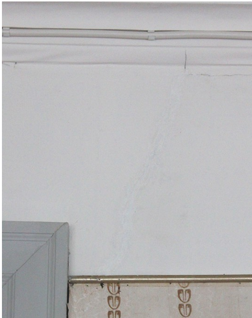
Kuvat 63. ja 64. Repeämä pahvissa ennen ja jälkeen paikkauksen
