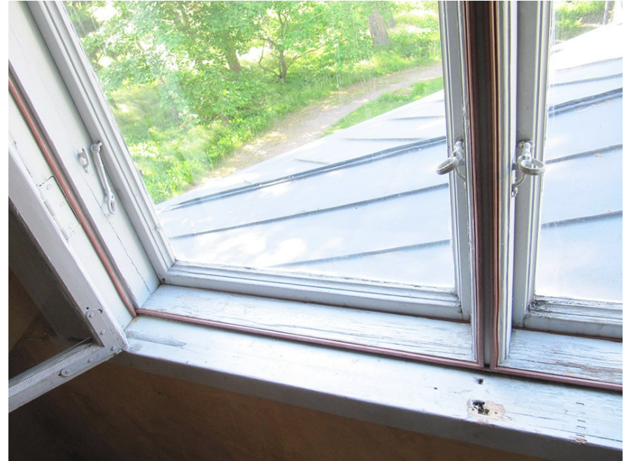
Kuva 66. Portaikon ikkunan tiivistys
