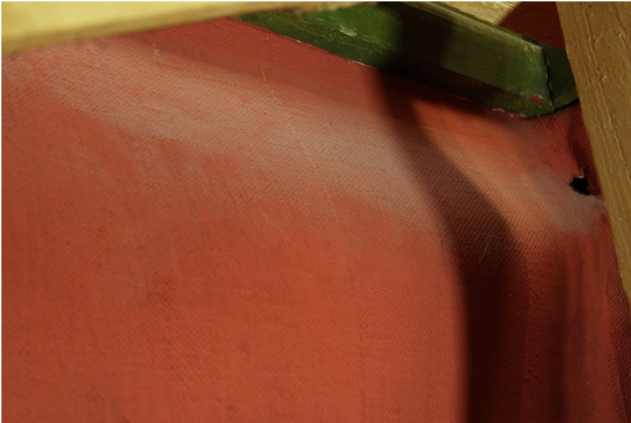
Kuva 5. Kupruilevan pahvin pintaan on kerääntynyt pölyä
