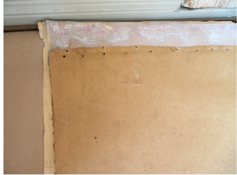
Kuva 44. Pahvin ja tapettireunan taustapuoli. Pahvi oikeenemassa lattialla
