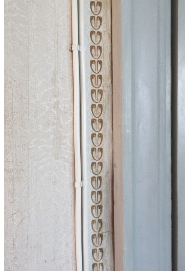
Kuva 59. Listan alle siistitty reuna ja laserattu listan sivu
