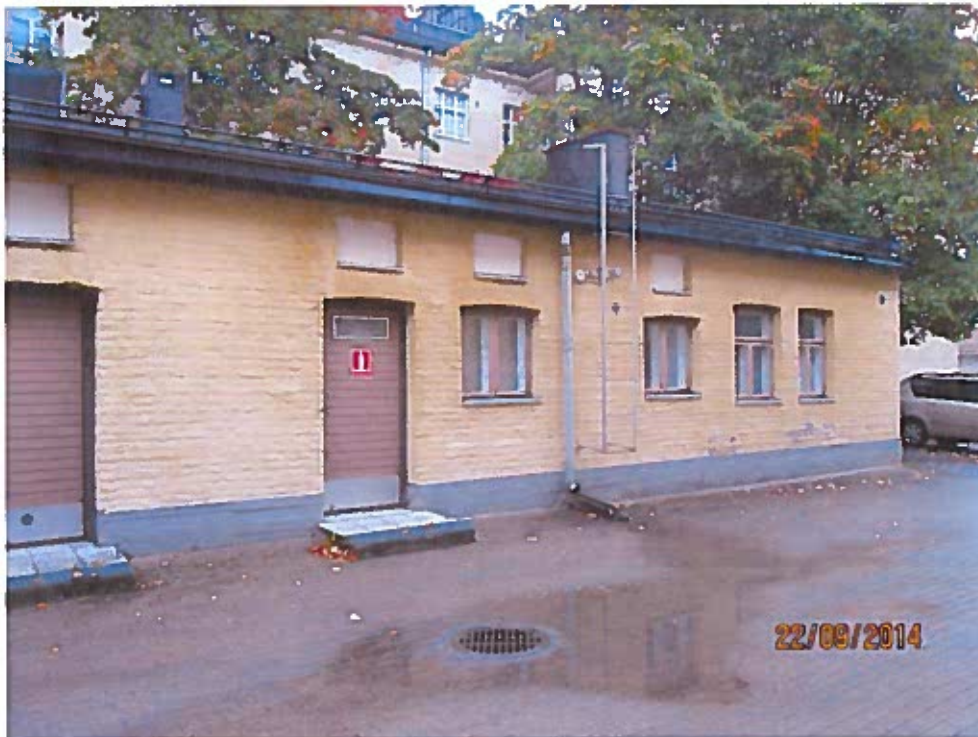
Piharakennus 1920-luvulta. Peruskorjaus 1988-89, esim. rappaus.
