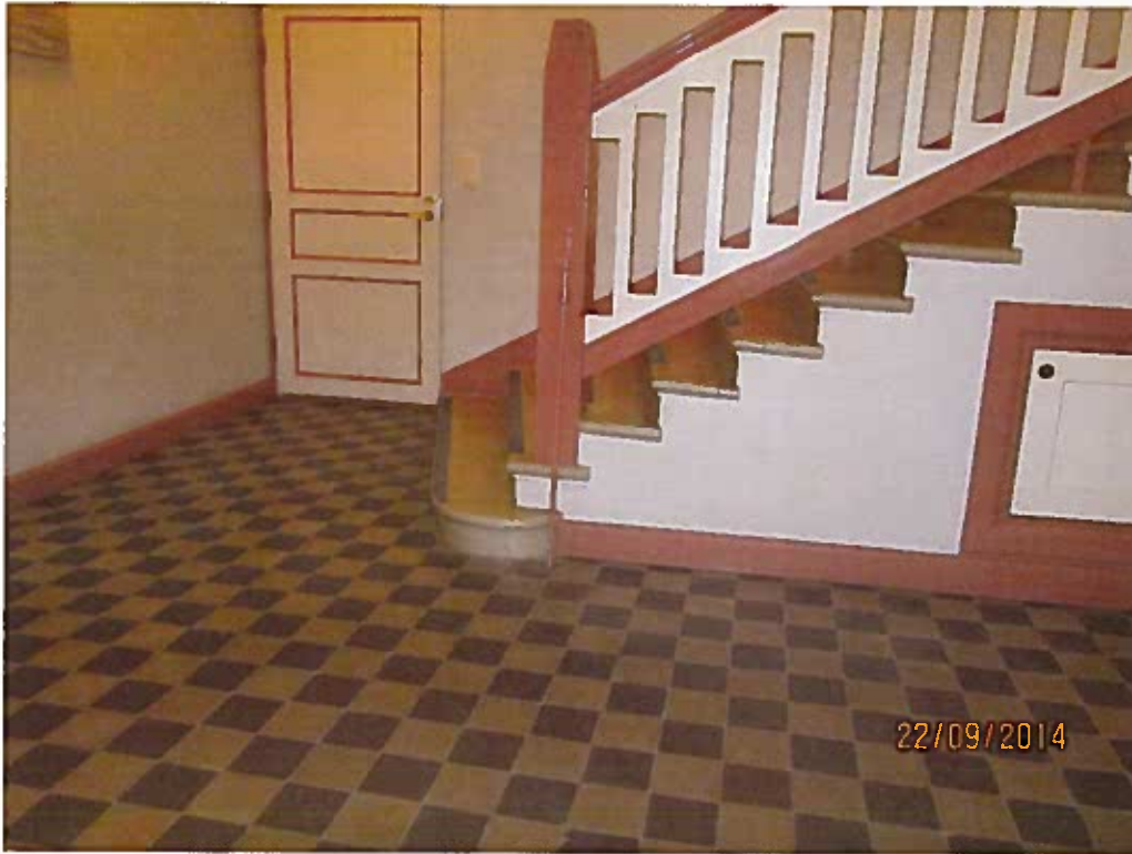
Porrashuone 1920-luvulta pintamateriaaleineen.
