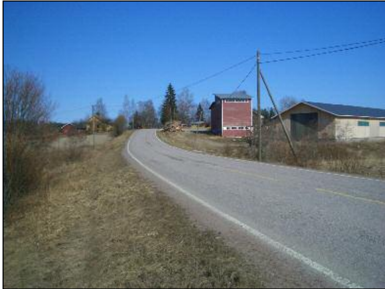
Koisjärven kylätontin länsipää punaisen rakennuksen kohdalla. Kuvattu itään.
