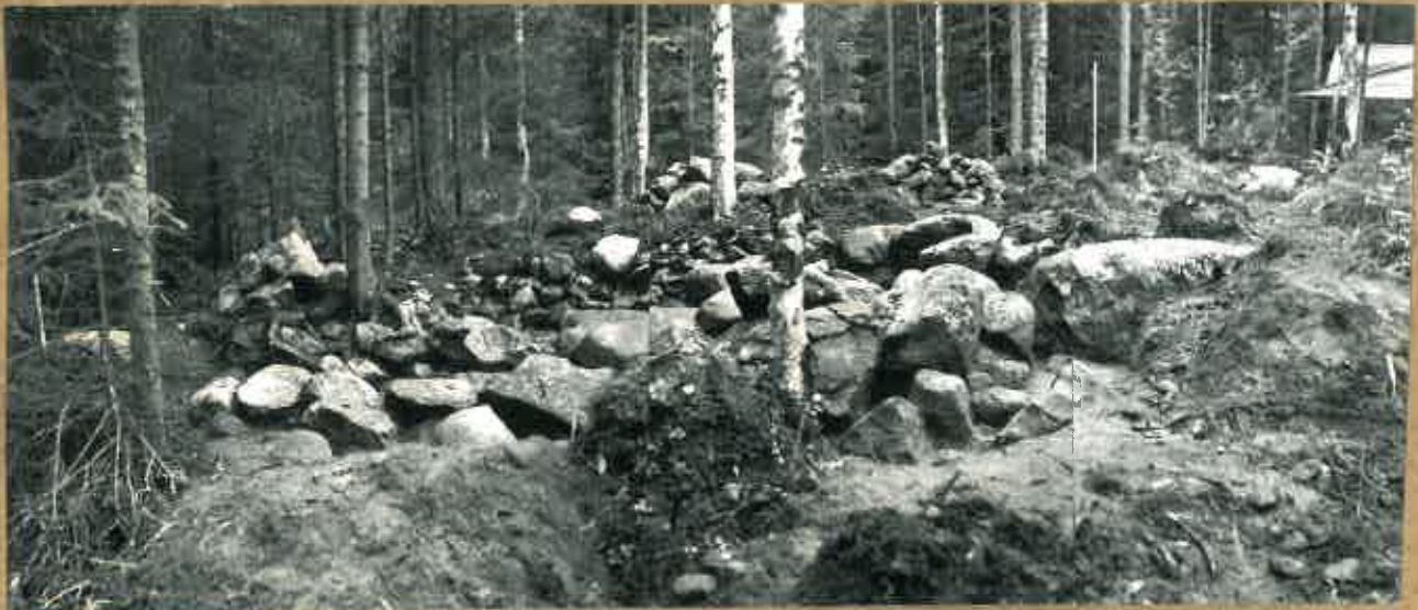
F. 98226-28 RÖYKKIÖN ITÄPUOLI, KUVAUTTU IDÄSTÄ, KIVIKERROS III
