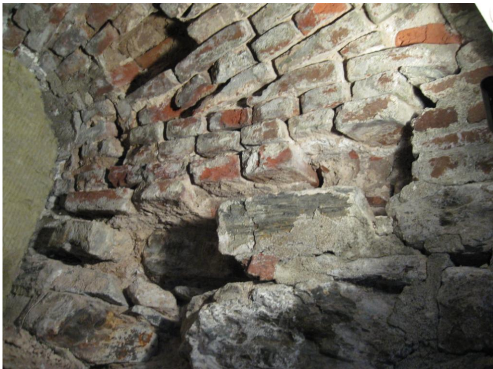
KUVA 8. Osittain purettua luonnonkiviosan pullistumaa (L-409)
