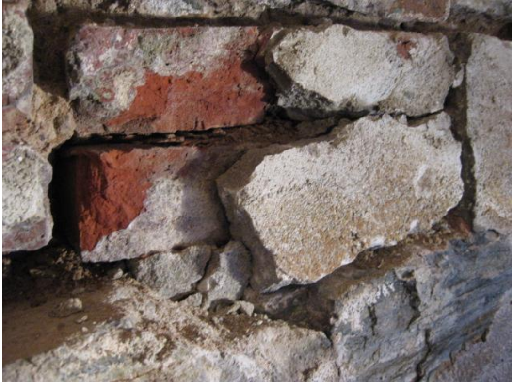
KUVA 7. "Rappauksen" alta paljastuneita tiiliä (L-409)
