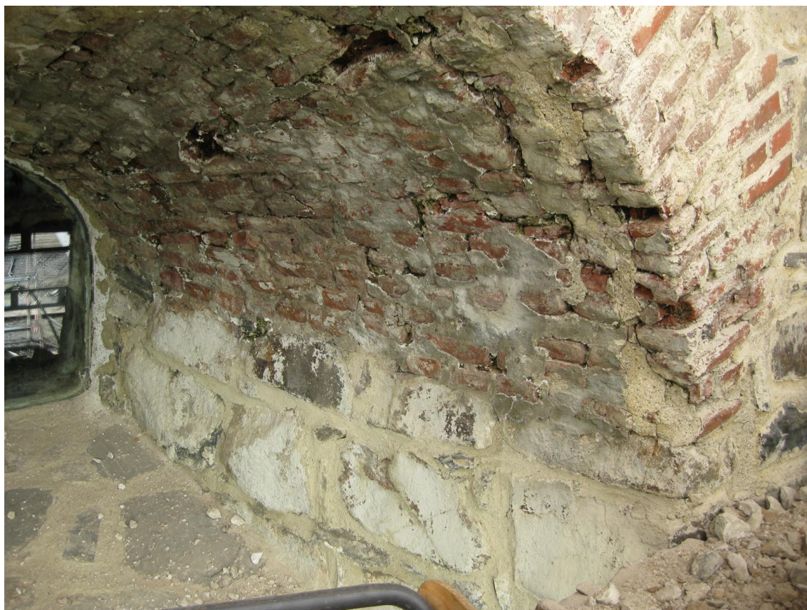
KUVA 1. Ampuma-aukko (L-105) ennen työn aloittamista.
