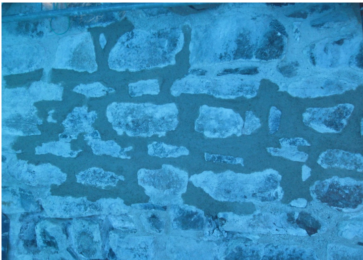
KUVA 5. Muuria saumauksen jälkeen.
