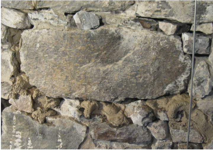
KUVA 4. Muuria pumppauksen jälkeen.
