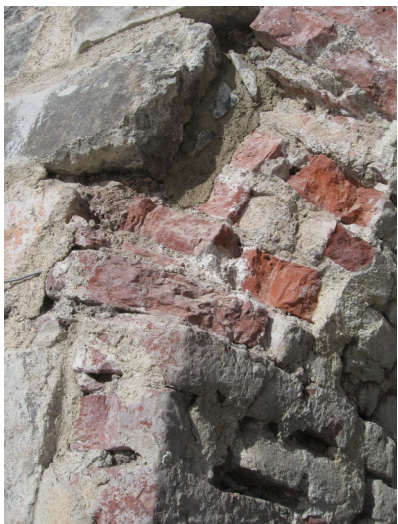
KUVA 11. Holvikaaren ja luonnonkiviseinän välissä oleva rako paikattiin luonnonkivilaastilla.
