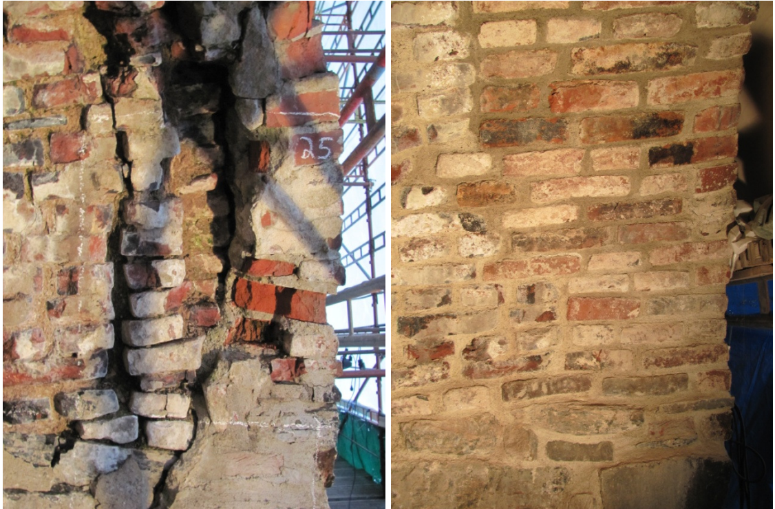
KUVAT 3 ja 4. Ampuma-aukon oikea sisäreuna jouduttiin muuraamaan lähes kokonaan uudelleen, jotta rakenteesta saatiin sitova.
