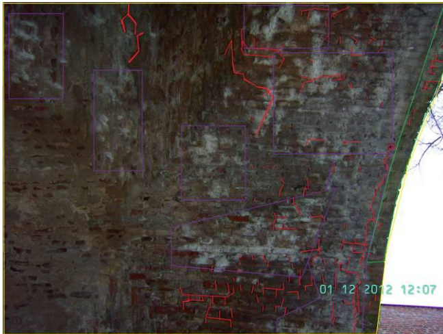
KUVA 17. I c, halkeamia kulkee ristiin rastiin ja uloin tiilivarvi on irtautumassa.
