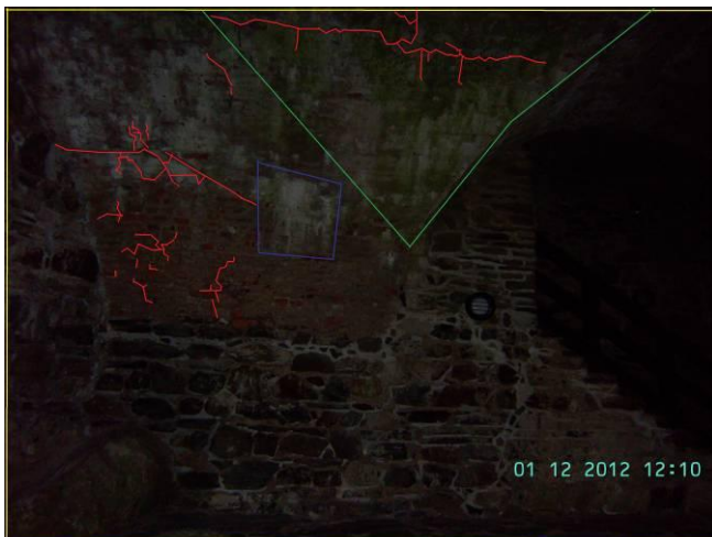
KUVA 22. III a, kosteus rakenteessa lisääntyy ja sen mukaisesti myös vauriot. Leväkasvustojen väri terävöityy. Ruoteen poikki kulkee halkeama.
