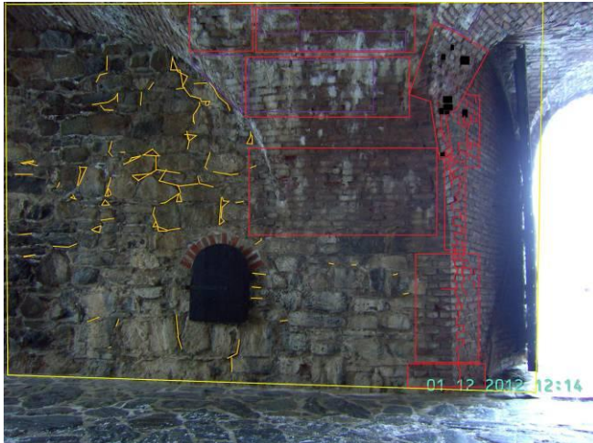
KUVA 32. VIII a, sisääntulon nurkkaus on kovalla rasituksella.
