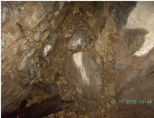
KUVA 7. Onkalon märkä lattia ja maatuvaa puuainesta.
