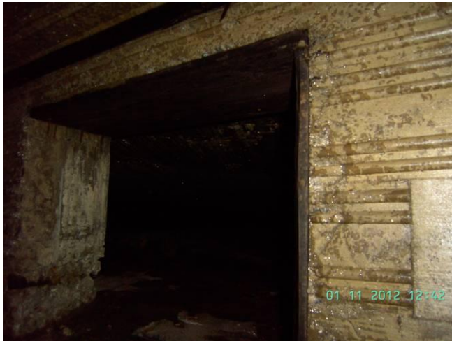
KUVA 8. Kurtiin matalaan välitilaan johtava aukko.
