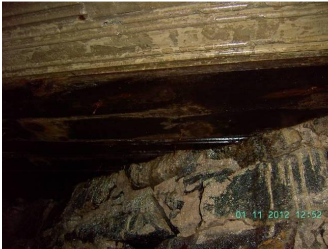
KUVA 6. Onkalon päässä on myös paikoilleen jätettyä laudoitusta.
