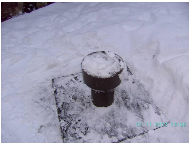
KUVA 2. Kurtiin yläpuolinen tarkistusaukko.
