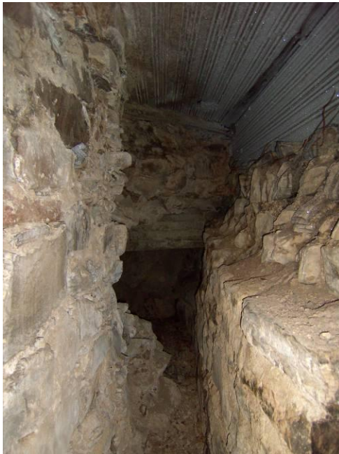
KUVA 4. Onkalo kulkee kurtiinien välitilassa sen pitkittäissuunnassa. Kuva on otettu helmikuussa, jolloin rakenteet ovat jo jäässä.
