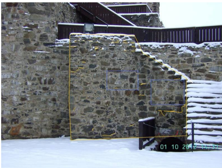
KUVA 42. Pieniä puutteita saumauksien kunnossa on ja kalkkiset valumat ovat esteettinen haitta, joka on helposti vältettävissä huolellisella työllä.
