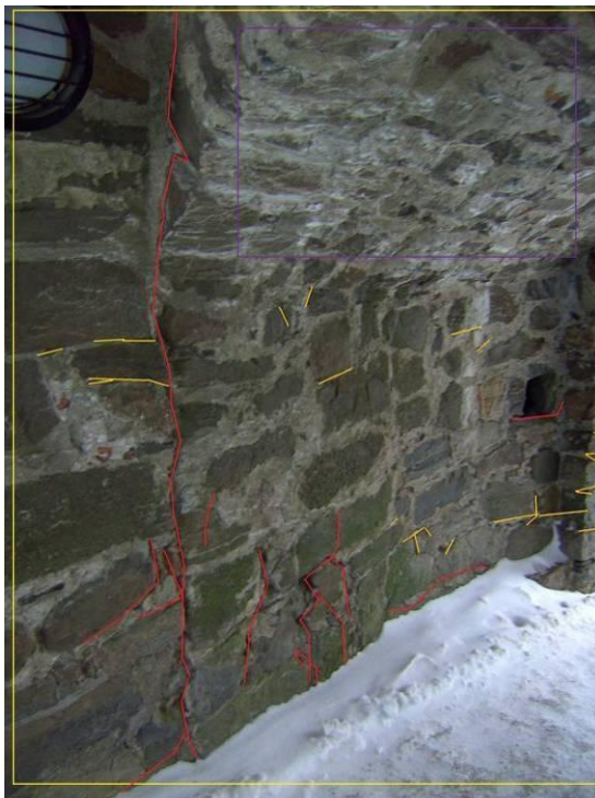
KUVA 12. Vasemmalla, toisen holvin liittymäkohdassa näkyvä halkeama.
