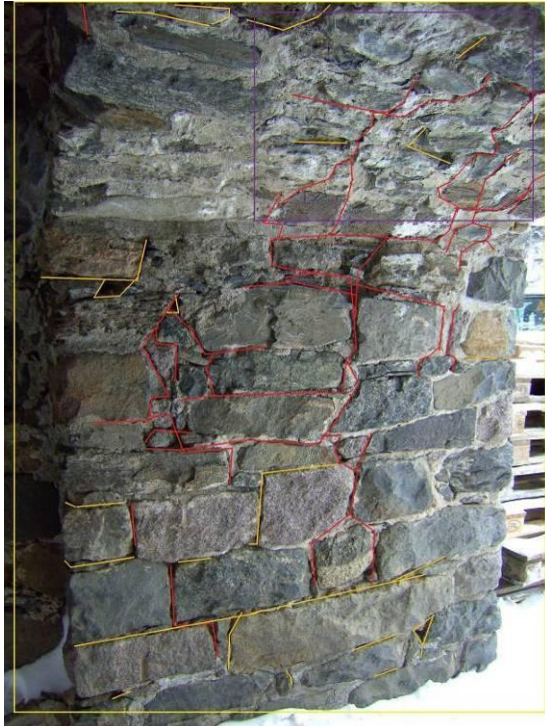
KUVA 14. Portaalin vasemmanpuoleinen seinämä on repeytynyt.
