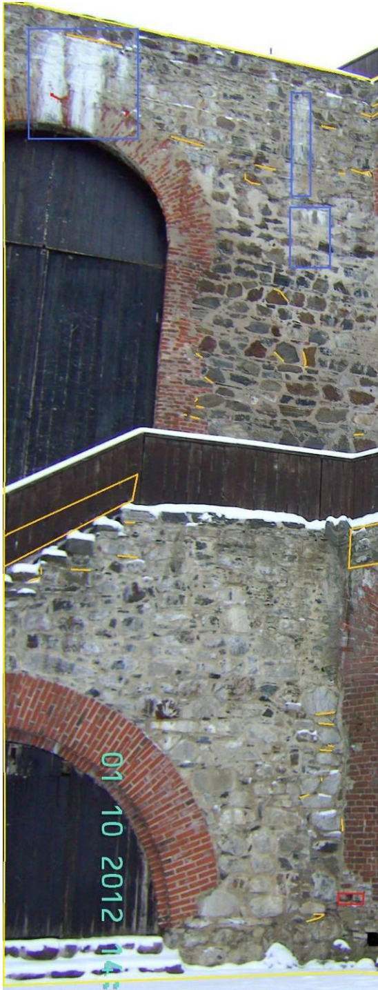
KUVA 28. Muuria hallitsee ruma kalkkinen valuma oven yläpuolella.
