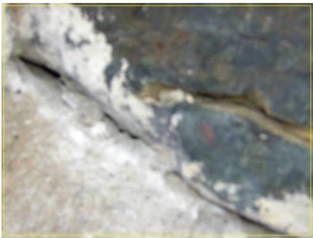
KUVA 4. Kuvasta voi havaita, että laasti ei ole tavoittanut kiven pintaa lainkaan. Sauman tiiviysvaatimus ei täyty.
