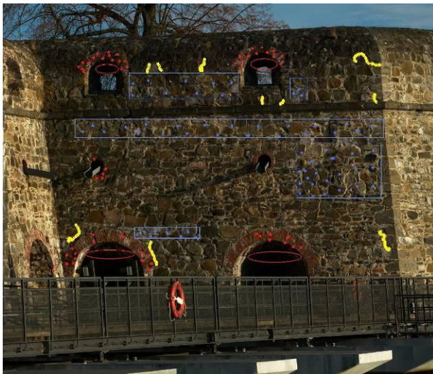
KUVA 2. Vesiportin bastionin I muuri.
