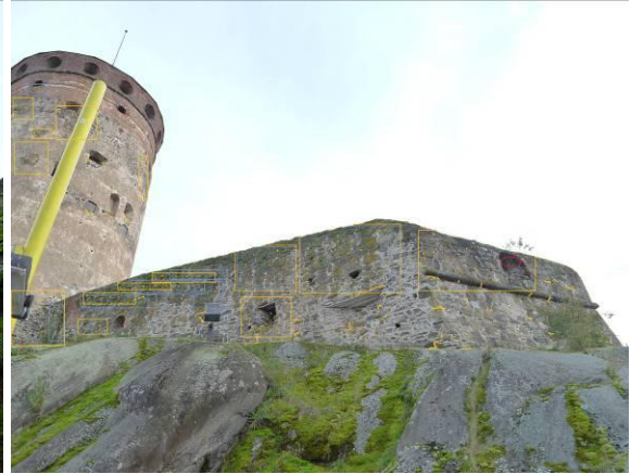
KUVA 28. Kellotornin III sivu ja kellobastionin I ja II muuri.
