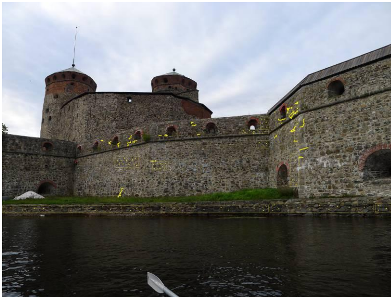
KUVA 6. Vesiportin ja Pikkuportin bastionin välinen muuri.
