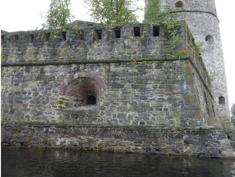
KUVA 17. Suворov, muuri IV, as.21, oikea. Muurissa on kasvustoja, saumauksien uusimista ja tiiliosioiden restaurointia.
