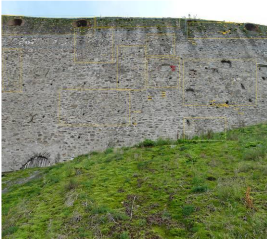
KUVA 23. Kijlin tornin ja Kirkkotornin välinen muuri II. Saumattavaa riittää.
