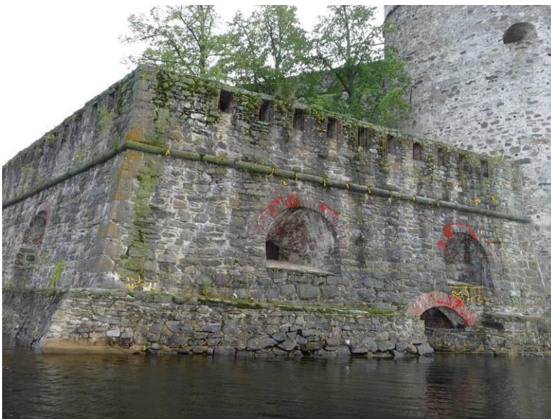
KUVA 18. Suворov, muuri V. Vauriot jatkuvat samankaltaisina.
