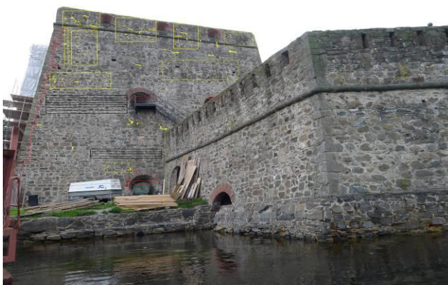
KUVA 12. Työt etenevät tällä hetkellä (talvi 2011) Paksun bastionin muurilla III.
