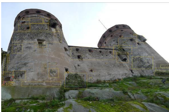
KUVA 26. Kirkkotornin II sivu ja Kellotornin I sivu sekä niiden välinen muuriosuus.
