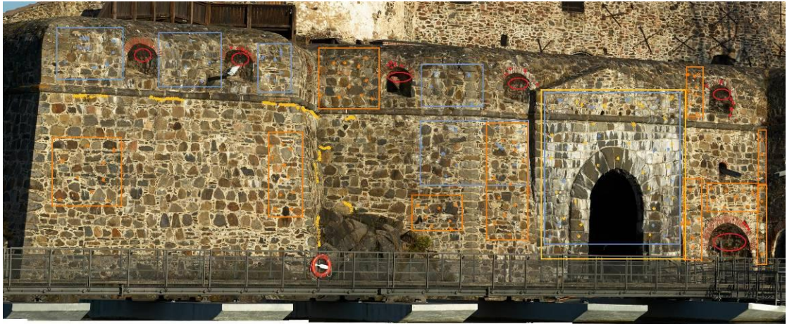
KUVA 30. Kellobastionin III, IV ja V muuri jossa sijaitsee myös pääsisäänkäynti.
