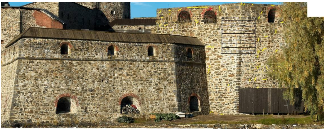
KUVA 10. Eteläpatterin muurit I ja II. Pullistumat nostavat luokituksen AAA.
