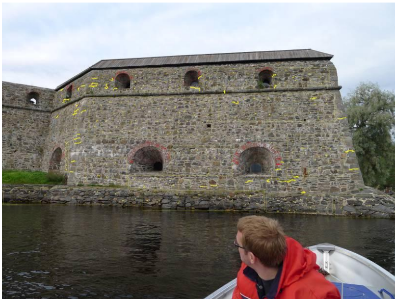
KUVA 7. Pikkuportin bastionin muurit I ja II.
