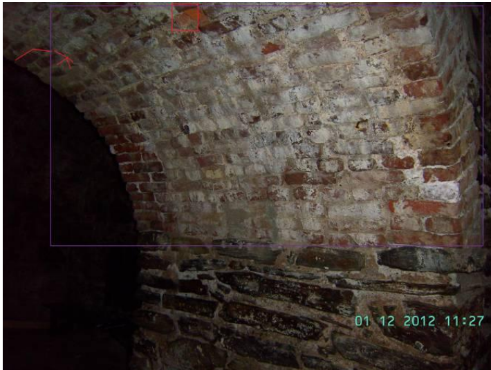
KUVA 118. I c, väliholvin oikea puoli on suolan peitossa.
