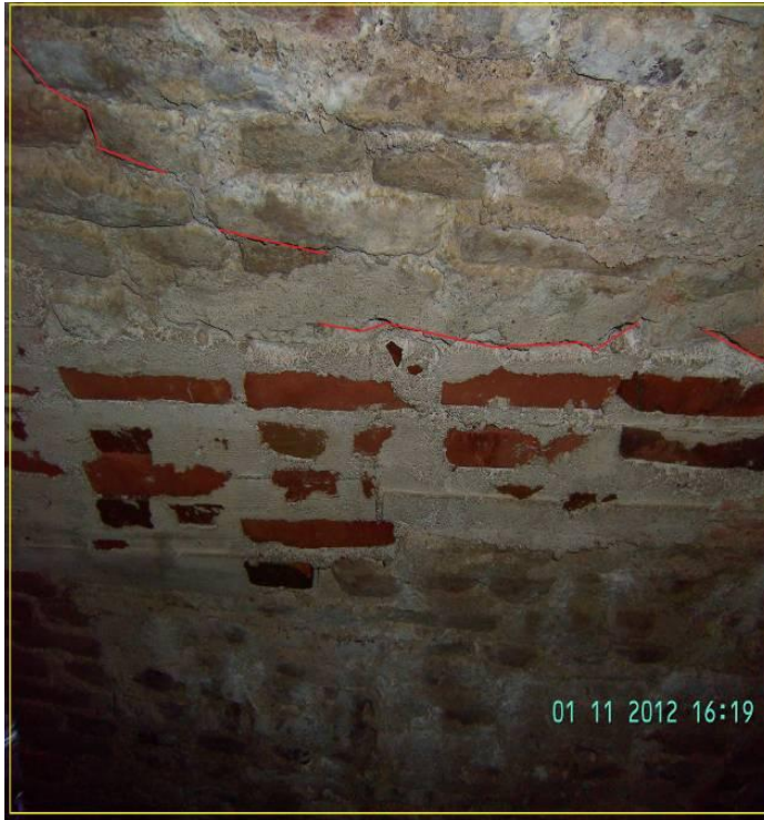
KUVA 98. I c, holvin aiempi korjaus on pettänyt.
