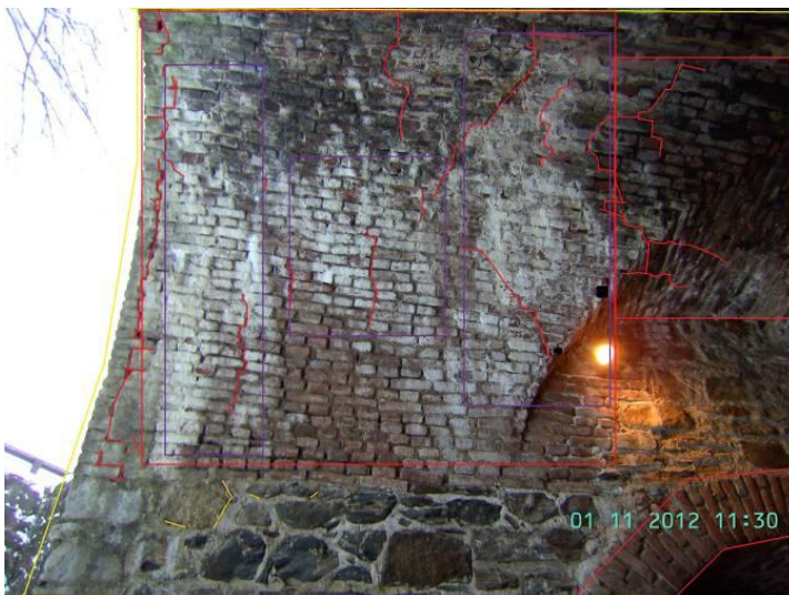
KUVA 22. I b, tiilikaareissa on halkeama ja holvissa halkeama.
