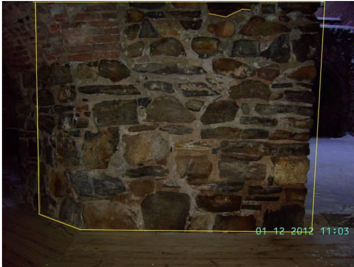
KUVA 103. II a, muurissa ei ole vaurioita.
