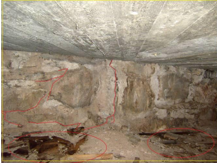
KUVA 5. Kivimuurin pystyhalkeama.
