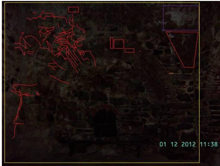
KUVA 127. III a, takaseinältä erottuu punaisella merkityt vauriokohdat.
