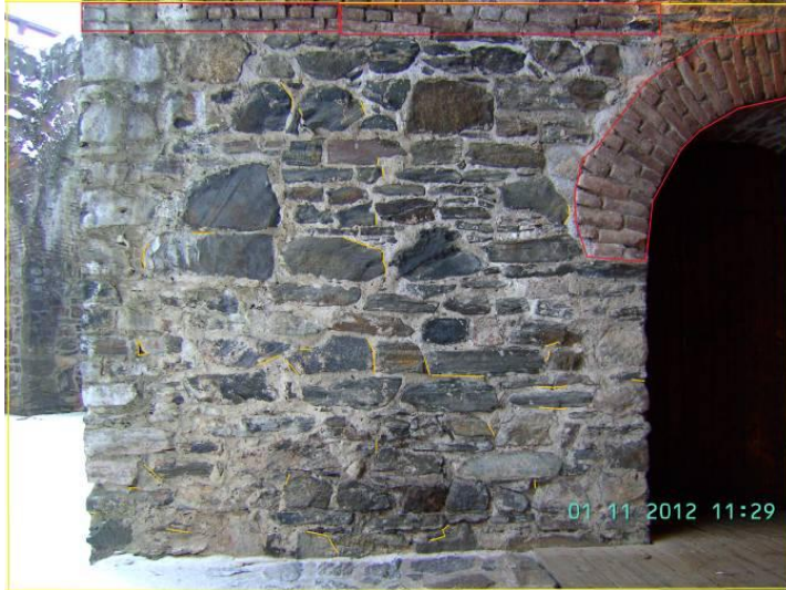
KUVA 21. I a, kivimuurit ovat suhteellisen hyvässä kunnossa.
