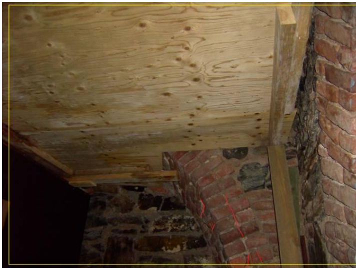
KUVA 53. Tiilikaassa on halkeama.
