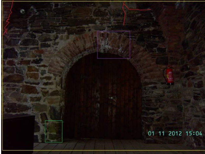
KUVA 43. II a, kivimuurissa on pystysuoria halkeamia.
