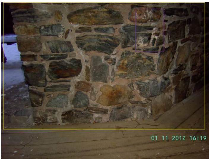
KUVA 96. I a, kivimuuuri on aiemmin korjattu ja se on kunnossa.
