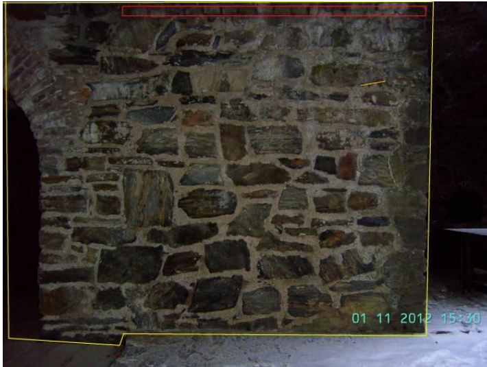
KUVA 60. I a, kivimuuri on kunnossa.
