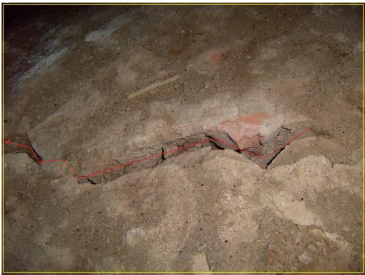
KUVA 14. Holvin etupuolella on repeämä.
