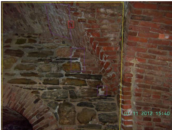
KUVA 71. V b, suola heikentää rakennetta pitäen sen kosteana.
