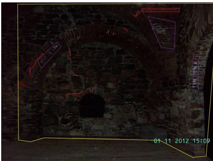
KUVA 46. III a, takaseinän halkeamat ja ruoteen halkeamat kaipaavat toimenpiteitä.
