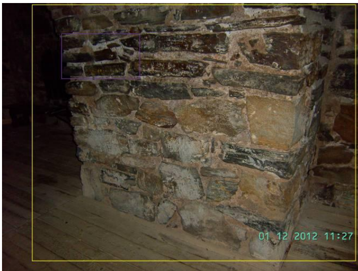
KUVA 119. I d, oikealla puolella myös kivimuurissa on suolaa.
