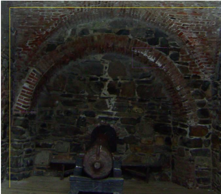
KUVA 68. IV a, takimmainen seinämuri on suhteellisen hyvässä kunnossa.
