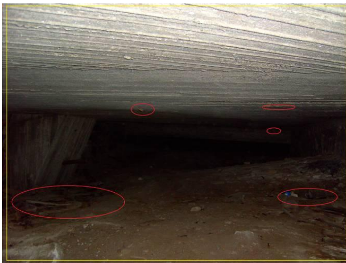
KUVA 11. Viidennen kasematin holvit vaikuttavat olevan kunnossa.
