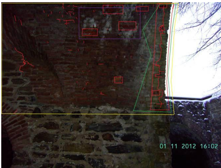
KUVA 83. I b, kaaren uloin tiilivarvi on täälläkin irtautumassa.
