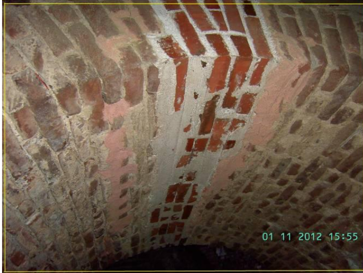
KUVA 79. I c, väliholvin kaarikin on kunnossa.
