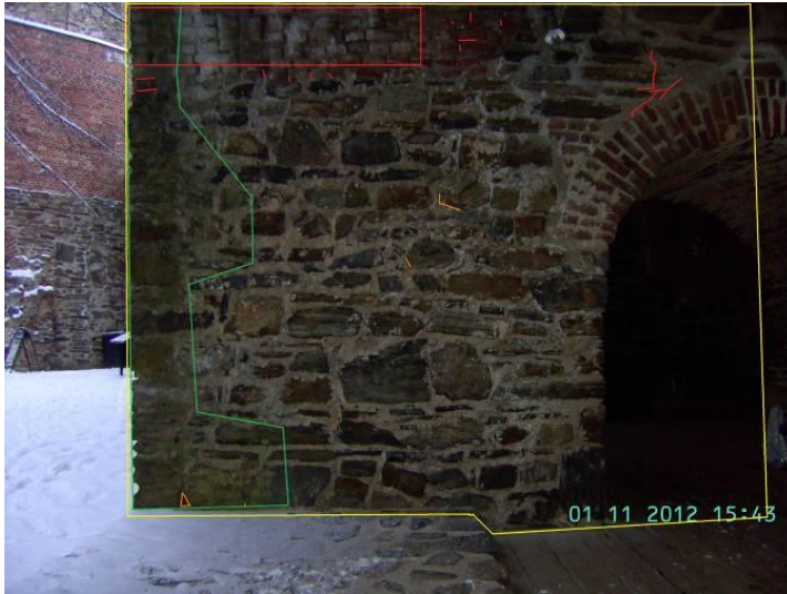
KUVA 74. VII a, alaosassa on leväkasvustoja.
