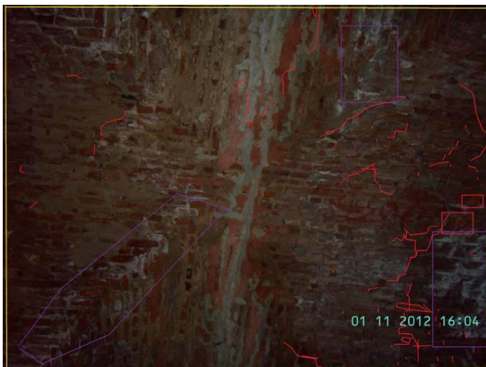
KUVA 87. II c, holvissa on suolaa ja pieniä halkeamia.
