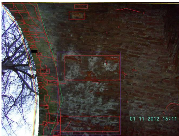
KUVA 95. VII c, tiiliaines on heikentynyttä ja kaaresta on jo pudonnut tiili pois.
