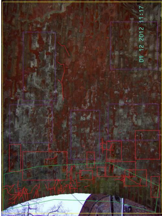
KUVA 115. VIII c, uloin tiilivarvi on irtautumassa ja myös muut kaaren ja hovin tiilet saattavat olla hyvin rapautuneita.
