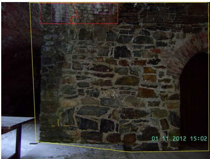
KUVA 40. I a, vasen seinämuuri on kunnossa.
