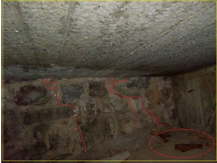
KUVA 9. Halkeamat kivimuurissa sijaitsevat lähellä tukipilareita.
