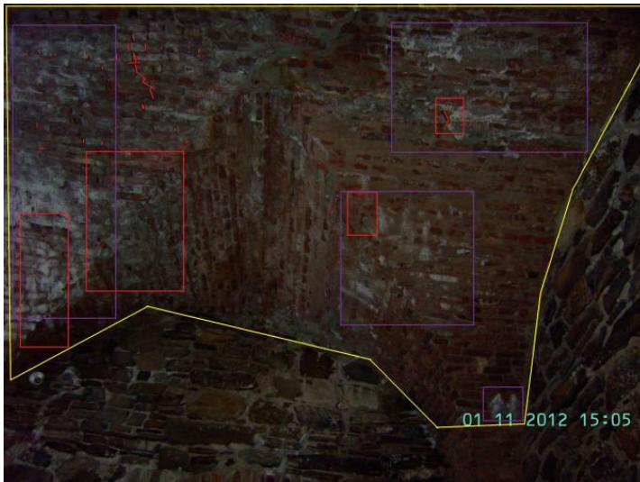
KUVA 44. II b, holvissa on suolaa melko runsaasti.
