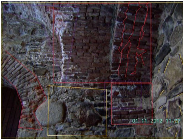
KUVA 28. III b, kaikki kuvassa näkyvät tiiliosiot kaipaavat saumausta.
