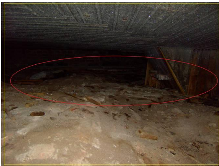
KUVA 18. Puutavaraa on varastoituna viimeisen kasematin päälle.
