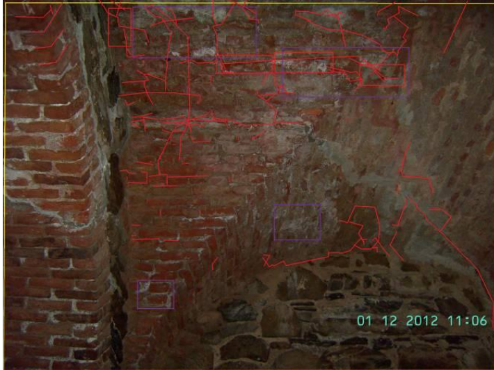
KUVA 107. IV b, holvissa risteilee halkeamia.
