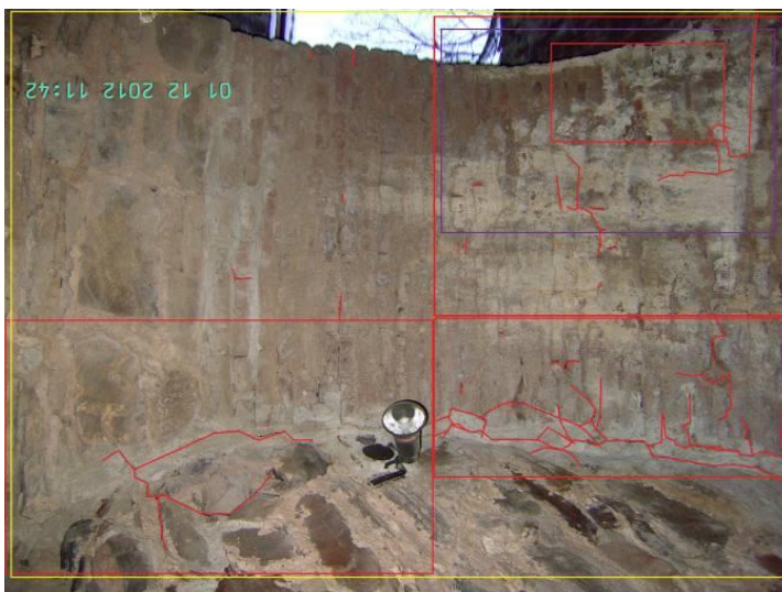
KUVA 132. IV b, kaaren alue alhaalta kuvattuna on rapautunutta.
