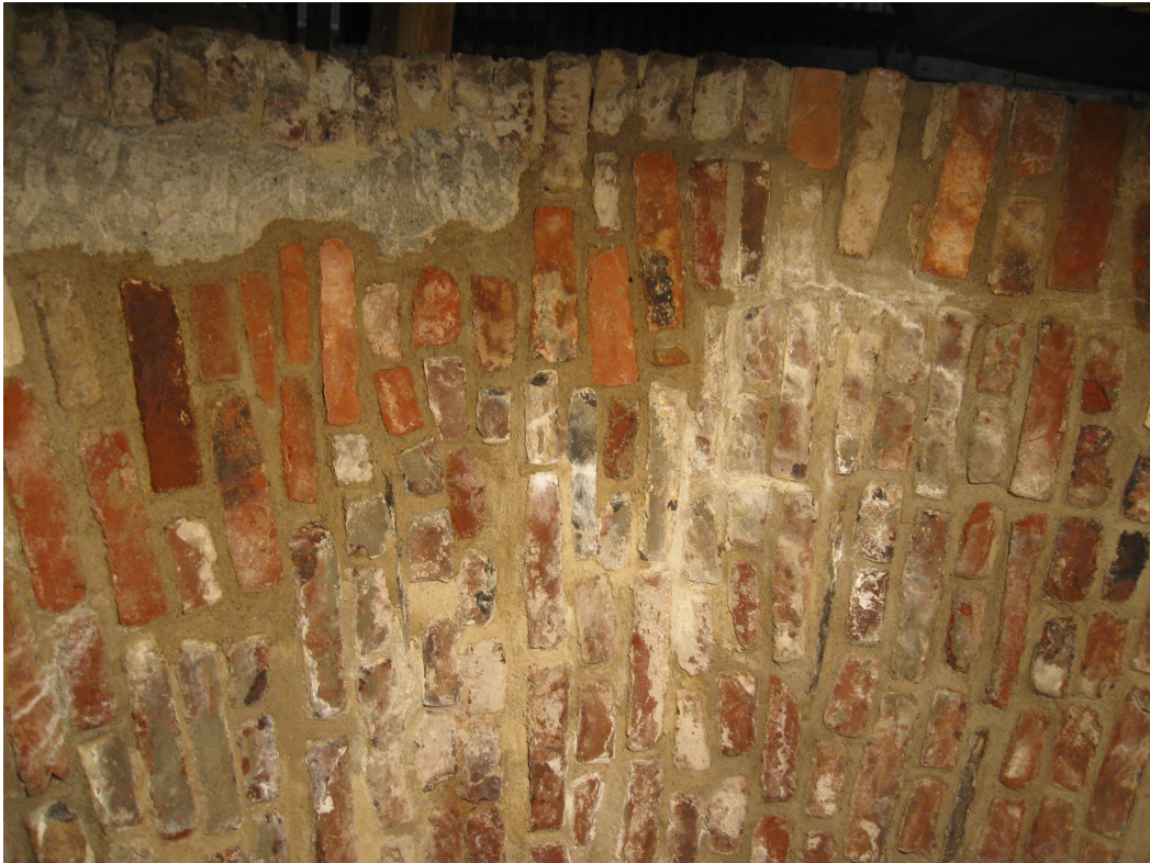
KUVA 2. Kuvan vasemmassa laidassa ylhäällä näkyy aukkoon jätetty täyttökorjaus.
