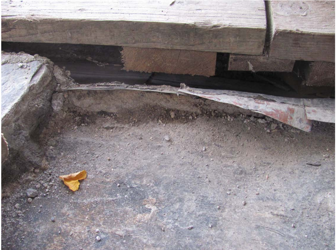
KUVA 13. Vesieristeen ja kuparipellin väliin jää rako.
