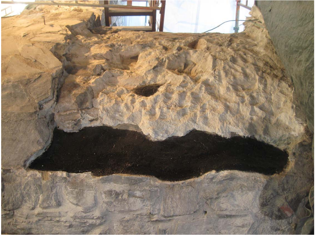
KUVA 8. Uusi Inducryl-sively ulottuu muurin reunaan saakka.
