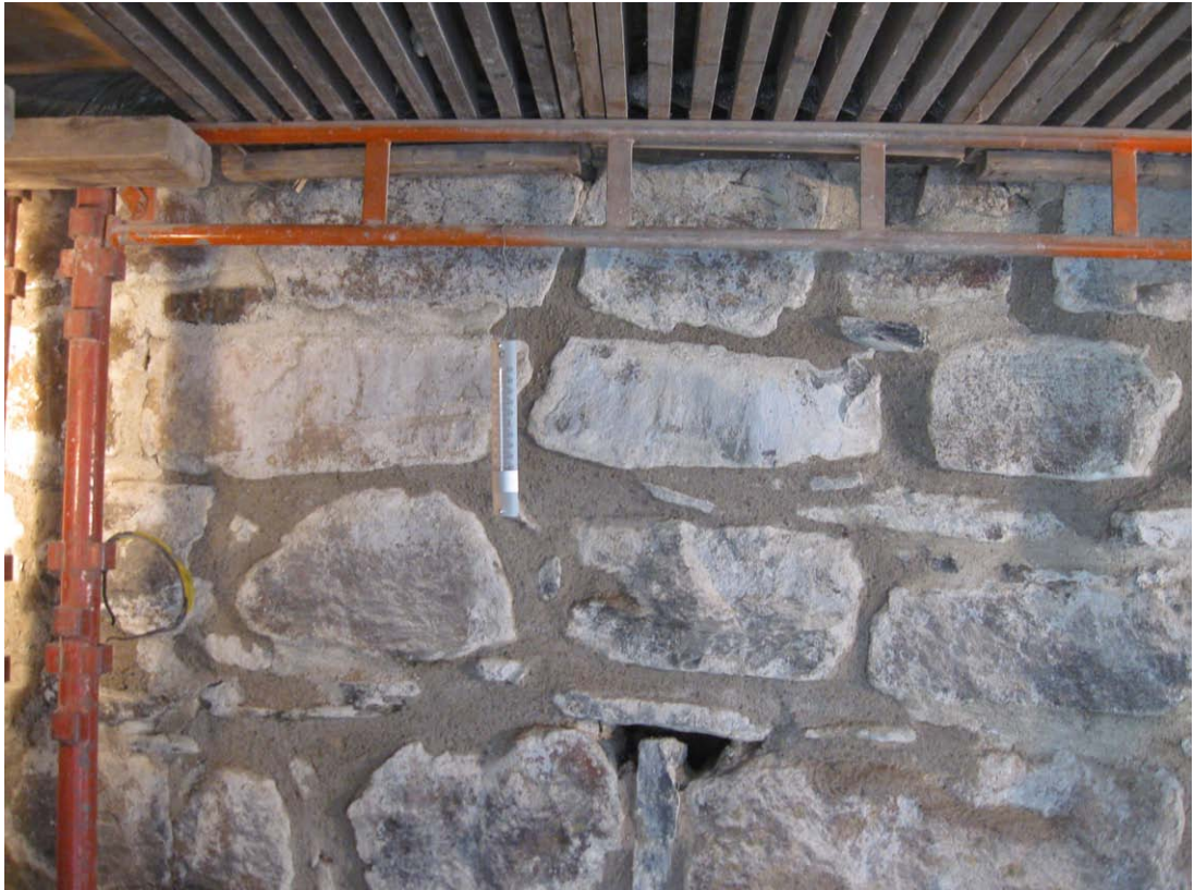
KUVA 5. Vastasaumattua aluetta ja syvätäyttöä varten jätetty aukko.
