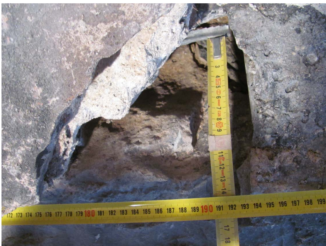
KUVA 6. Kuvan ylä laidassa näkyy lochrip-verkon reuna. Vaakatasossa oleva mittanauha kulkee kohdassa, jossa muurinharja ja bastionin ulkoseinä kohtaavat.
