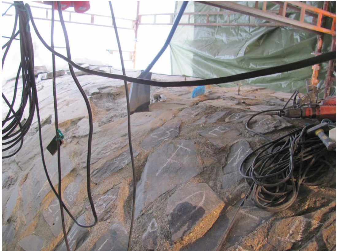
KUVA 7. Muurinharjan kivet merkittiin ennen piikkaustyön aloittamista.
