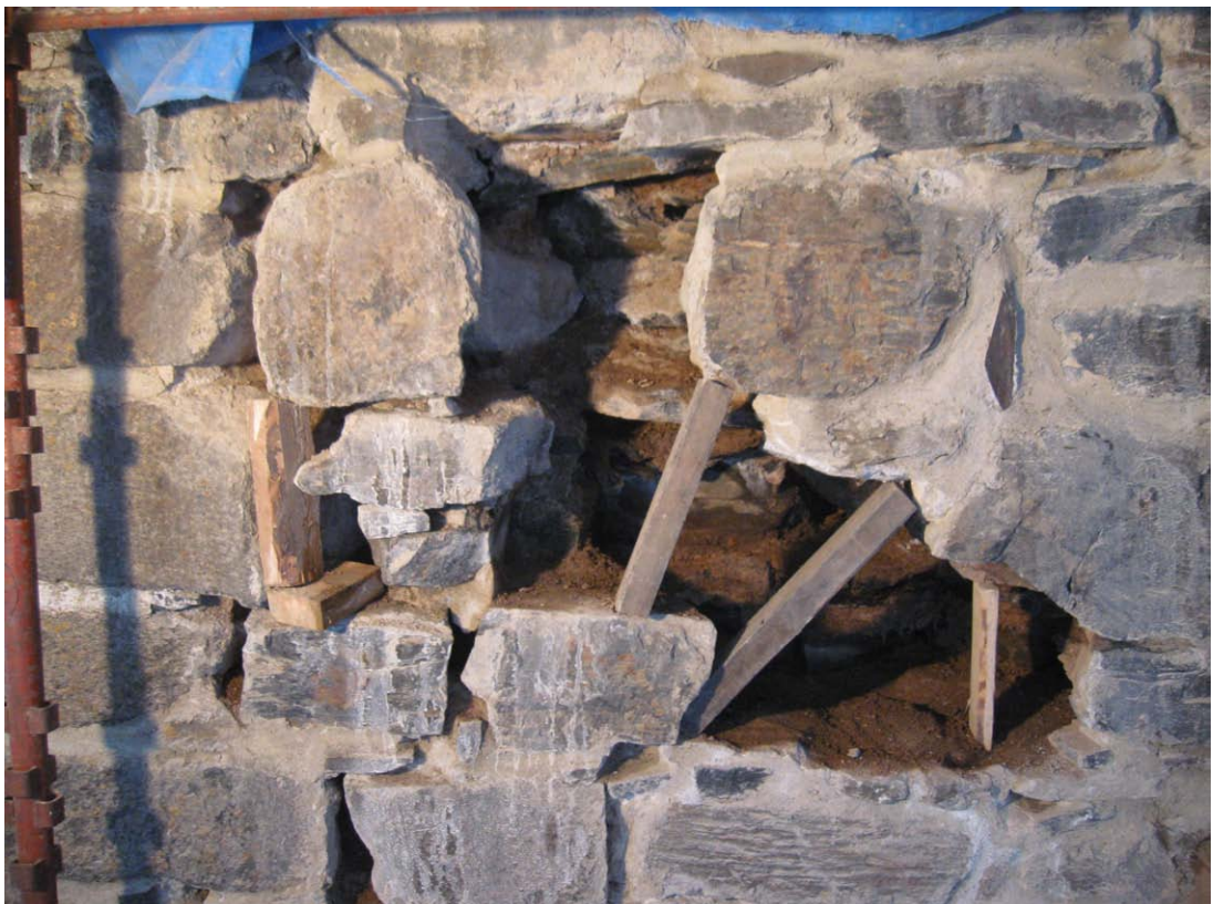
KUVA 15. Kaakkoiskulmasta jouduttiin poistamaan paljon haljenneita ja poikkinaisia kiviä. Aukot tuettiin puutuilla.
