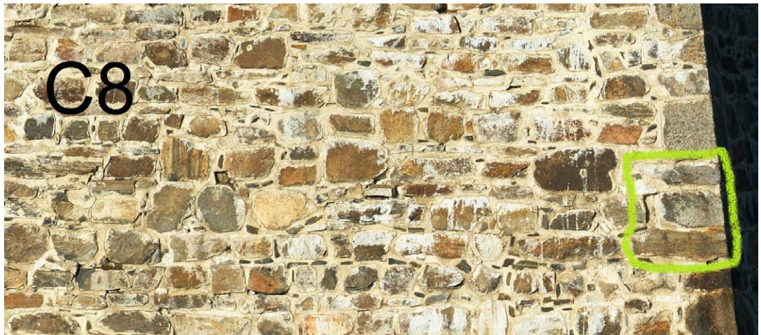
KUVA 16. Poikkeuksellisella tavalla muokatut nurkkakivet.
