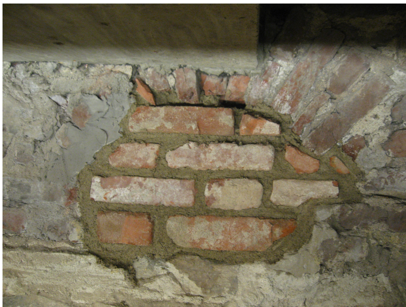
KUVA 4. Umpeenmuurattu aukko.
