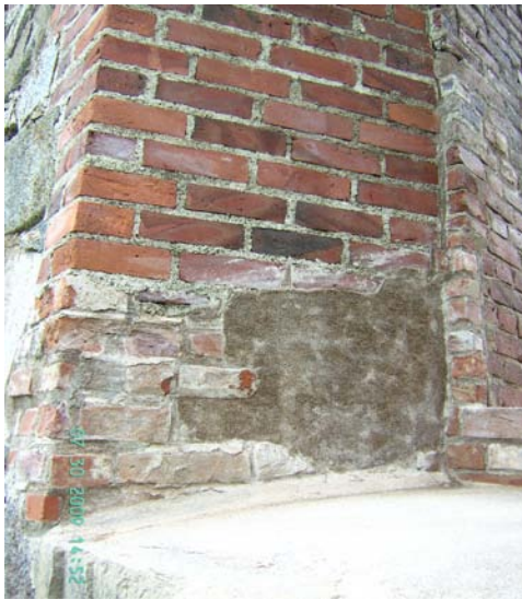
KUVA 41. Laasti kerros suojaa tiiliä.
