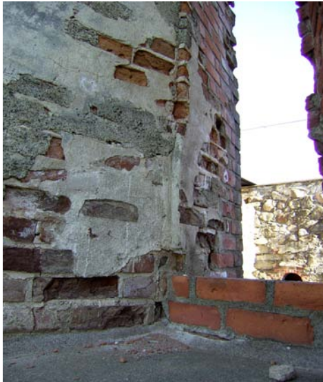
KUVA 43. Ikkuna-aukon A 2 vasen puoli.
