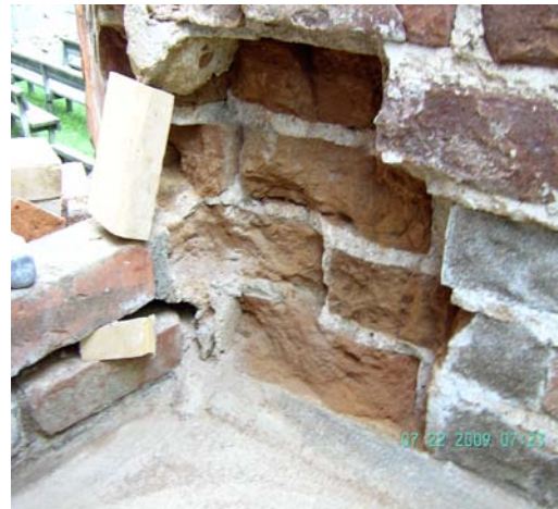
KUVA 39. Ikkuna-aukon A 1 oikea puoli. KUVA 40. Pehmennyt tiiliaines poistettiin.
