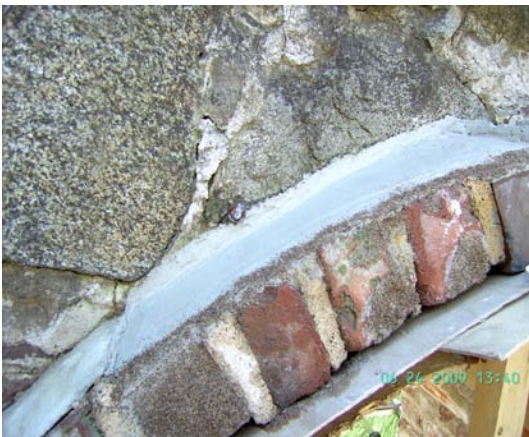
KUVA 23. Uusi laastipinta lyijylevyn alle.
