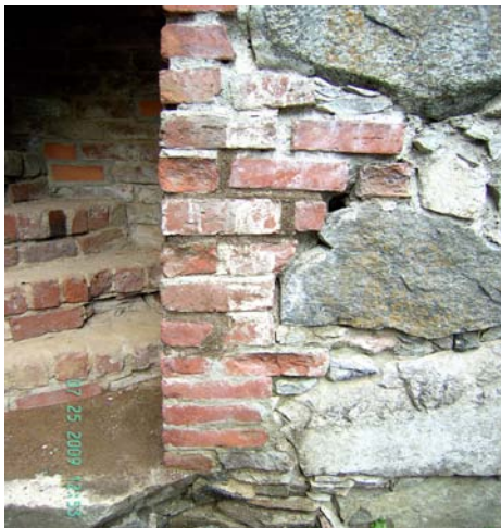
KUVA 56. Oikean puolen osittain saumattua pintaa.
