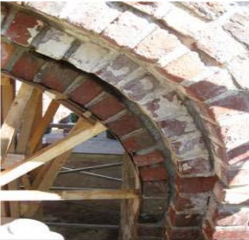
KUVA 17. Kiinnitettävien varvien ja uusittavien tiilien alla on puusta valmistettu tuki.
