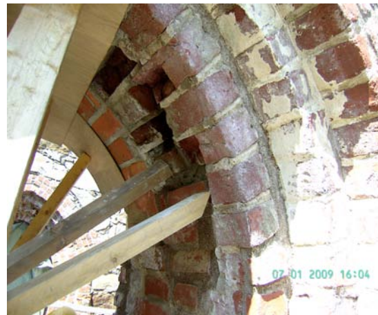
KUVA 30. Restaurointi suoritettiin asteittain. Ensimmäisessä vaiheessa uusien taustan ja sitten kiinnittäen tiilet.
