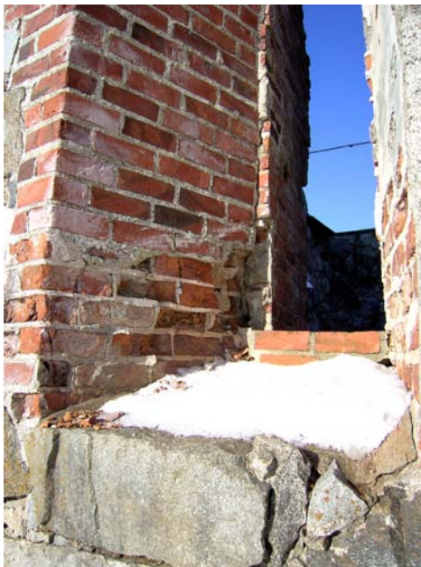
KUVA 37. Talvinen kuva lumen viipymisestä ikkunapenkillä A.
