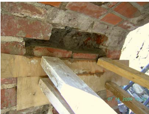
KUVA 33. Holvikaarimuurauksen työ aikainen tuenta.
