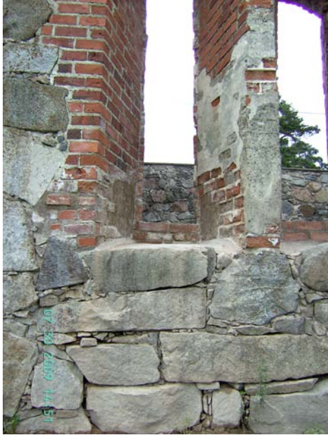
KUVA 47. Restauroitu ikkuna-aukko A 1. KUVA 48. Restauroitu ikkuna-aukko A 2.
