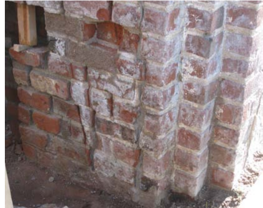
KUVA 20. Isokokoiset tiilet puhdistettiin ja käytettiin uudelleen.
