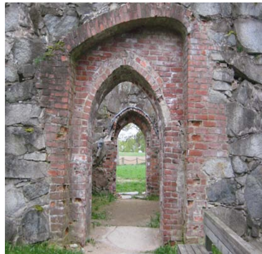
KUVA 5. Runkohuoneen ja asehuoneen välisen sisäänkäynnin erikoisuus on epäkesko holvikaari.
