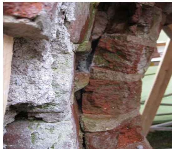
Kuva 22. Holvin irtonaiset tiiliosiot.
