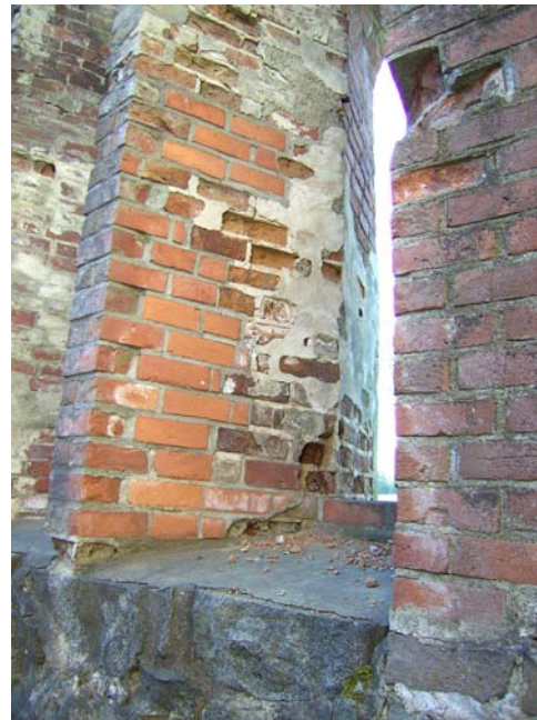
KUVA 50. Ikkuna-aukko A 1 vasen puoli ennen resturointia.
