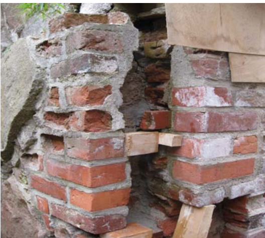
Kuva 21. Repeytymä rakenteessa.
