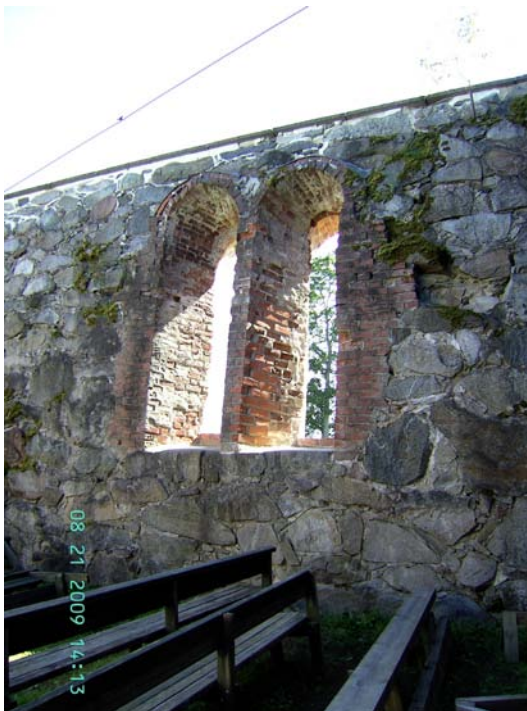
KUVA 52. Yleisilme on runkokuoneen puolelta siistiytynyt ja rakenteet ovat toistaiseksi turvassa.
