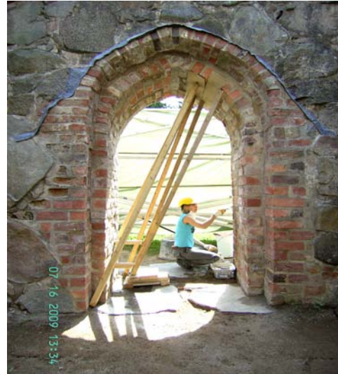
KUVA 36. Asehuoneen sisäänkäynti on restauroitu.
