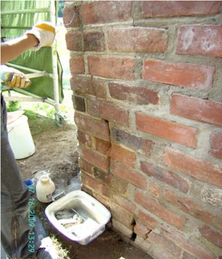
KUVA 35. Vähäisemmät pystysuorat halkeamat avataan ja täytetään.
