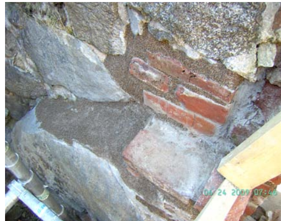
KUVA 26. Onkalo kiven takana täytettiin.
