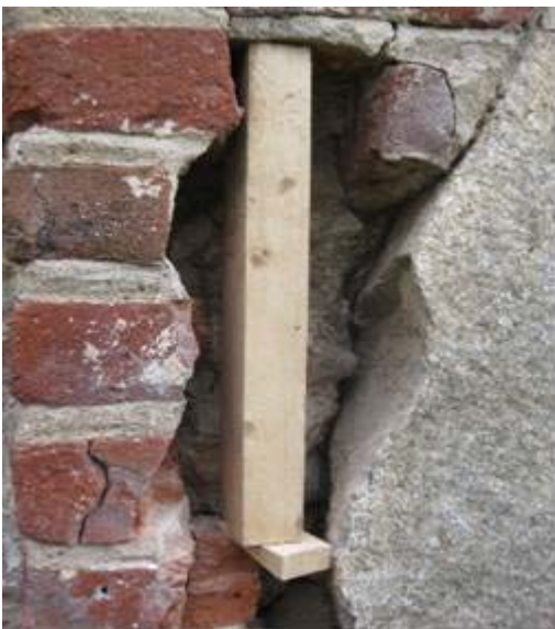
KUVA 14. Poistettujen tiilien muodostama aukko tuetaan kakkosnelosen palalla työn ajaksi.
