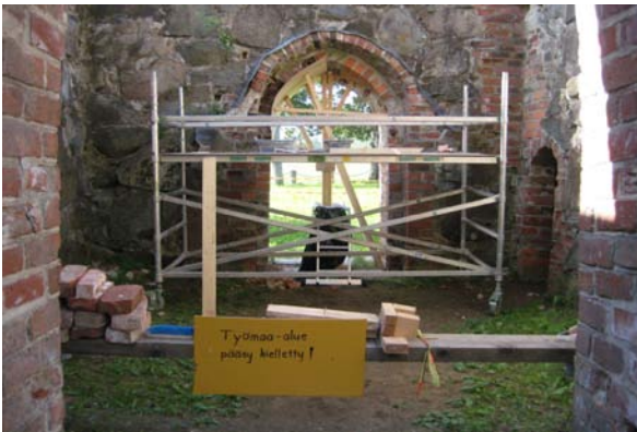
KUVA 1. Kulku asehuoneen sisäänkäynnistä oli estetty talven ajan.
