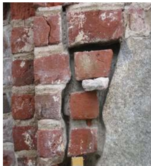
KUVA 15. Uudet tiilet muurataan rakenteeseen.
