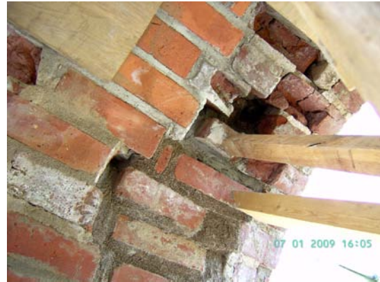
KUVA 32. Vauriokohta purettiin ja korjattiin asteittain.
