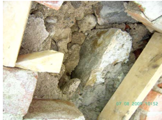
KUVA 28. Pyörökivinen taustarappaus uusitaan ja käytetään särmikkäämpiä kiviä.
