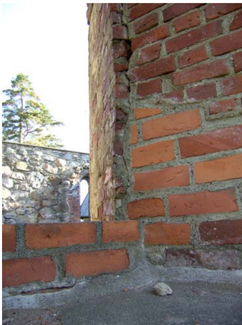
KUVA 45. Ikkuna-aukon A 2 vasen puoli.
