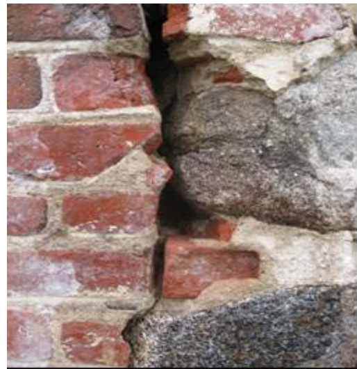
KUVA 13. Sauma puhdistetaan ja kastellaan.
