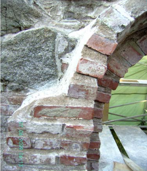
KUVA 27. Kaaren koko vasen sivu on menetetty ja siihen muurataan uusi osio.
