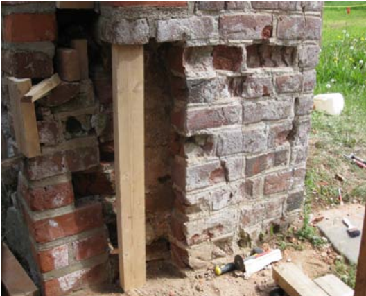
KUVA 19. Rakenteen tuenta uudelleen muurauksen aikana.
