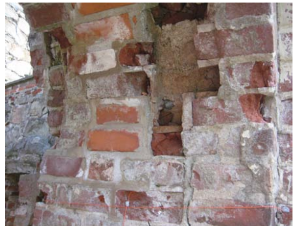
KUVA 9. Luja ja peräänantamaton sementtillaasti jouduttaa materiaalin menetyksiä.
