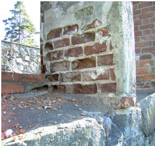
KUVA 39. Ikkuna-aukon A 1 oikea puoli. KUVA 40. Pehmennyt tiiliaines poistettiin.
