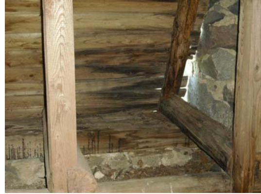
KUVA 6. Itälappeella riittää uloimman jalasorren osittainen paikkaus.
