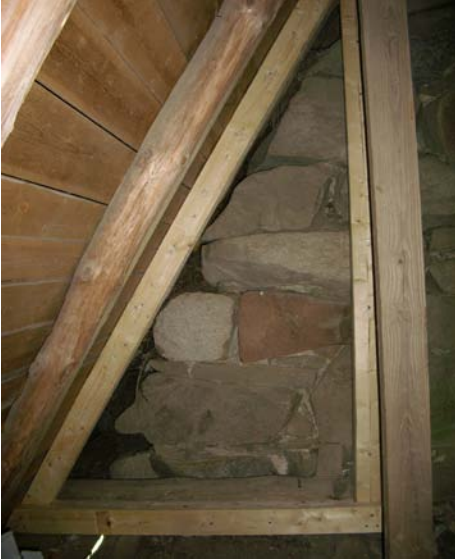
KUVA 15. Kontit, kápälät ja selkäpuut lisätuettiin.
