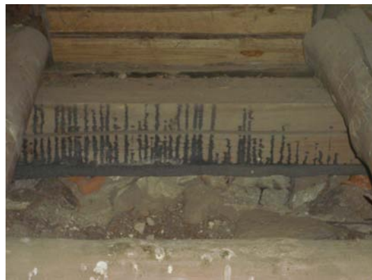
KUVA 28. Jalashirren alle asennetaan bitumikaistale.
