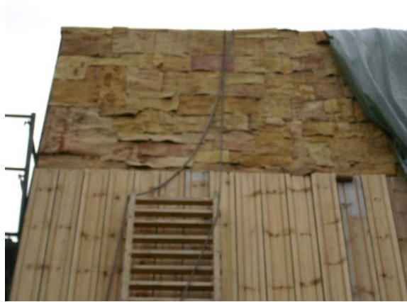
KUVA 34. Uralautojen asennus aloitetaan lappeelta, johon asennetaan I kerroksen pitkät laudat.
