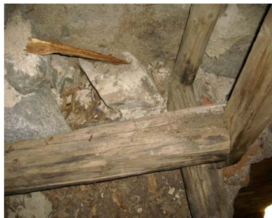
KUVA 4. Itälappeen kápälä on myös lahonnut.
