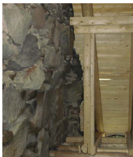
KUVA 18. Uusitut rakenteet yhteen liitettynä kokonaisuutena.
