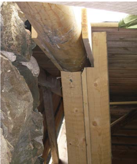
KUVA 17. Selkäpuun lapaliitos ja sen alle asennettu uusi vaakatuki ja kitapuu.
