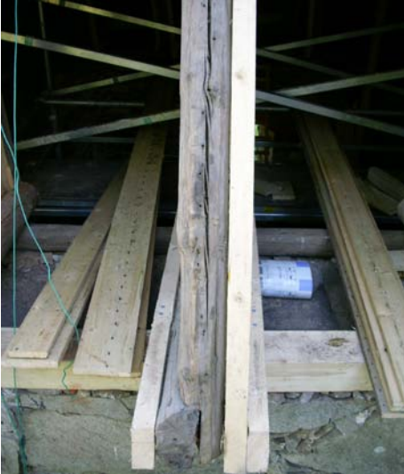
KUVA 21. Selkäpuiden tuenta ja Kämpälän uudelleen kiinnitys uuteen hirtehen.
