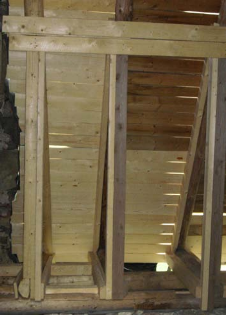
KUVA 19. Sisimmän jalasorren lahonnut osa korvattiin terveellä puulla kahden metrin matkalta.
