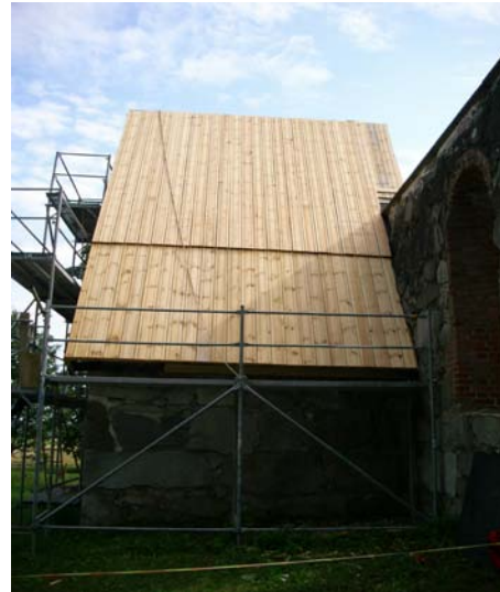
KUVA 36. Länsilapeen molemmat uralautakerrokset asennettuina.
