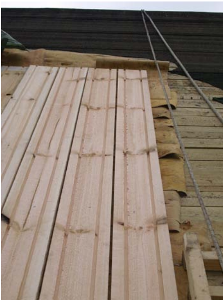
KUVA 33. Lautojen paksuus on 32 mm.
