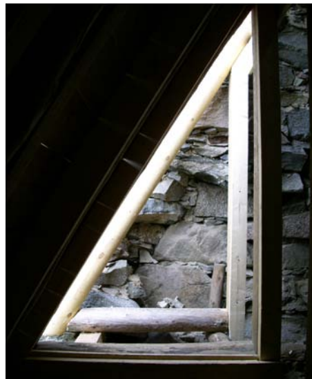
KUVA 26. Itälapteen uusitut tukirakenteet.
