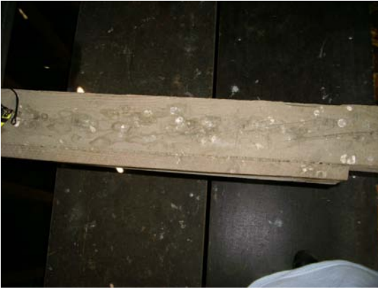
KUVA 9. II kitapuu pohjoisesta katsoen on jo aiemmin tuettu, joten tämä uusitaan.
