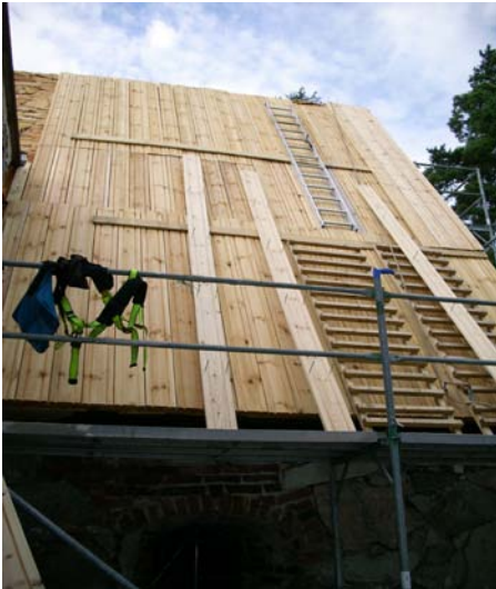
Kuva 35. II kerroksen ensimmäiset laudat ovat 2900 mm pitkät ja suorapäiset.
