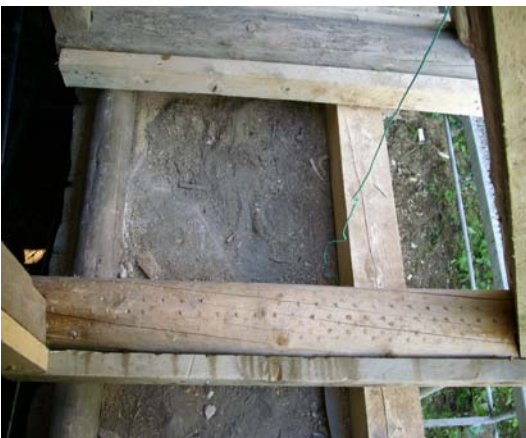
KUVA 13. Pohjoista katsoen toinen kypälä uusitaan ja asennetaan paikoilleen.
