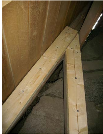
KUVA 16. Kontin ja selkäpuun tuennat kohtaavat poikittaisen tuen kohdalla.
