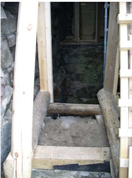
KUVA 27. Itälappeen uloin jalashirsi korjataan ja uusi osa asennetaan paikoilleen lapaliitoksella.
