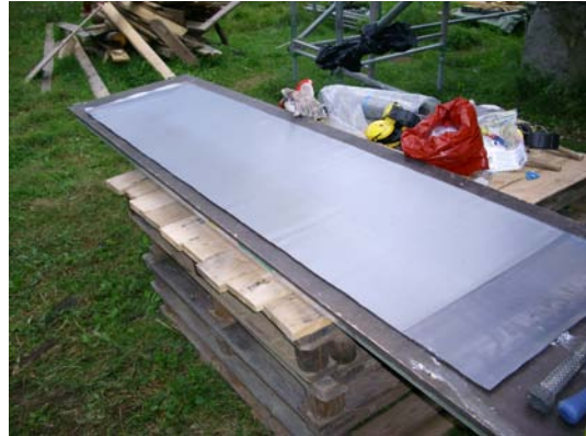
KUVA 39. Halkaistu lyijylevyrulla suoristettiin työstöä varten tasaiselle alustalle.
