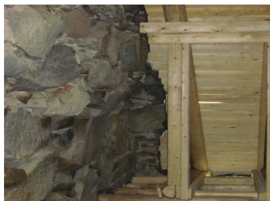
KUVA 24. Ulkonäöllisistä syistä lisätään vaakatasoon uudet laudat.
