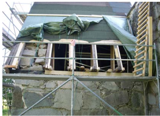
KUVA 20. Uusittu uloin jalashirsi.
