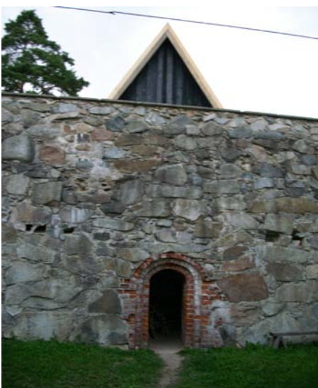
KUVA 37. Viime vaiheessa kiinnitettiin korjattu lauta päätykolmioon.
