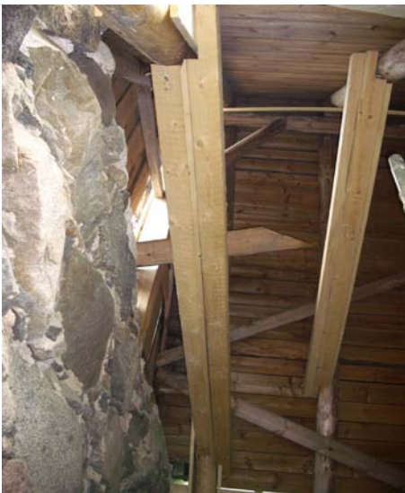
KUVA 25. Uusitut selkäpuut ja liitoksien vahvistamiseksi asennettu uusi vaakatuki ja kitapuu.
