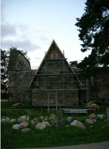
KUVA 42. Uudet otsalaudat antavat ryhtiä ja tuovat sakariston päädyn hienot tiilikoristelut paremmin esiin.
