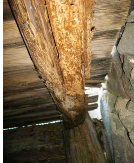
KUVA 8. Itälappeen selkäpuuta on heikentänyt ruskolaho ja hyönteisvauriot.
